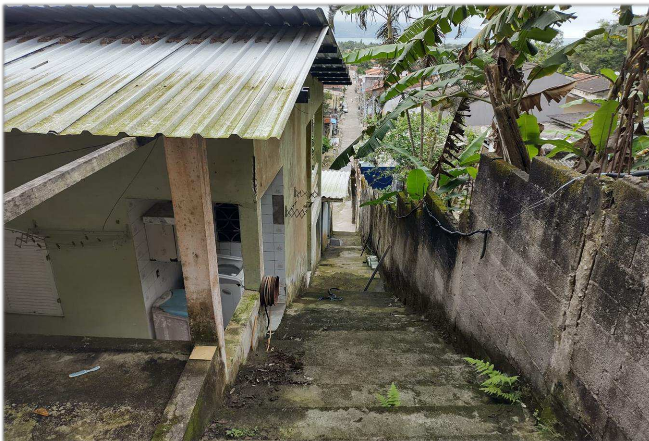
Visão contrária escadaria (3ª e 4ª unidade)
