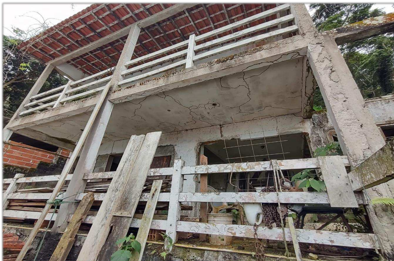
Visão fachada sobrado (3ª e 4ª unidade)
