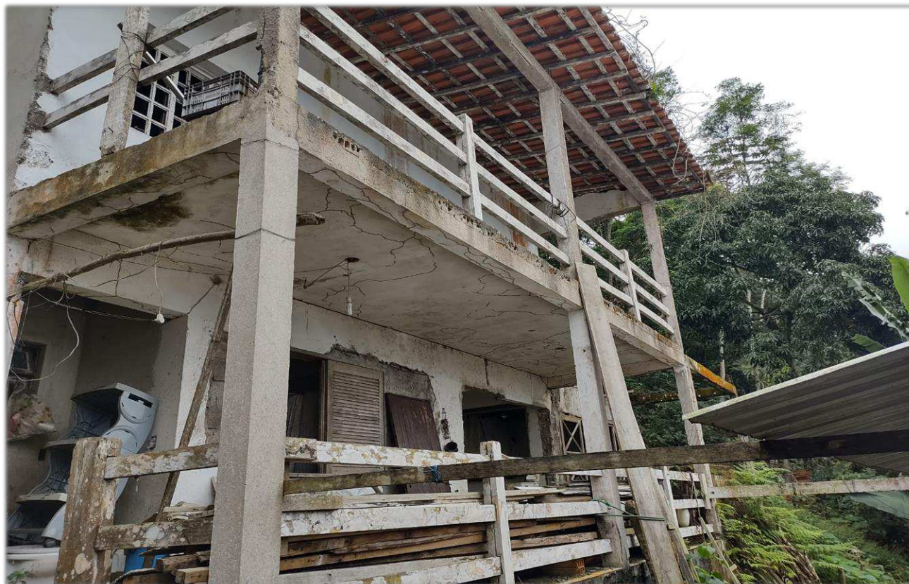
Visão fachada sobrado (3ª e 4ª unidade)
