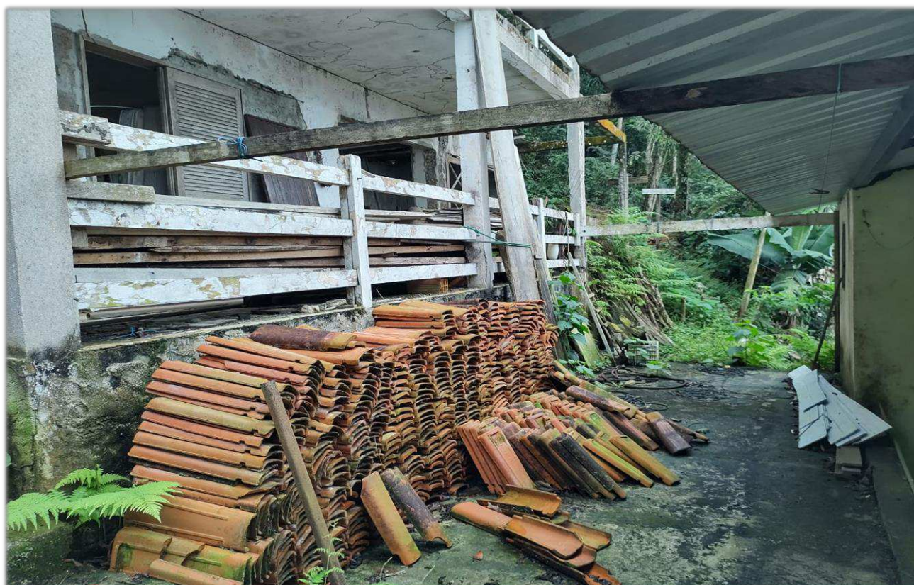
Visão fachada sobrado (3ª e 4ª unidade)
