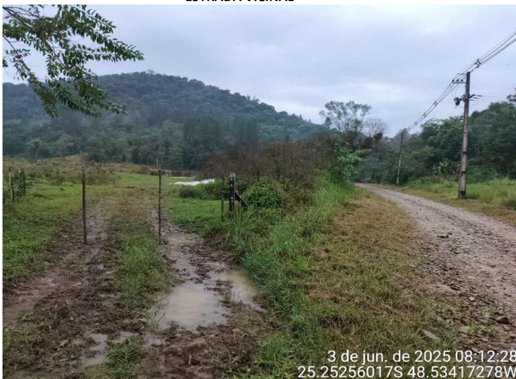
ENTRADA DA ÁREA E ESTRADA VICINAL COM POSTEAMENTO.
