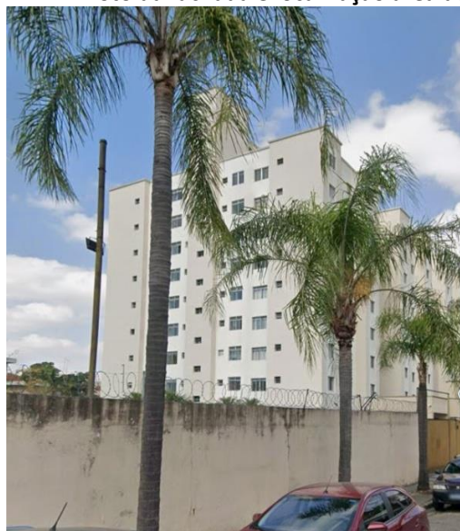
Foto da fachada do imóvel
