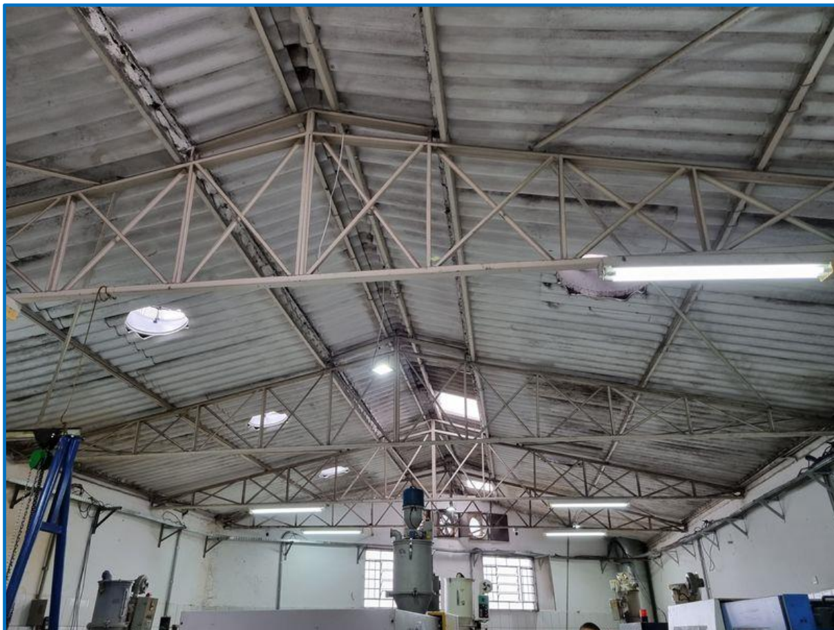
Foto 48 - Vista da cobertura da “Benfeitoria 02 – Galpão”.
