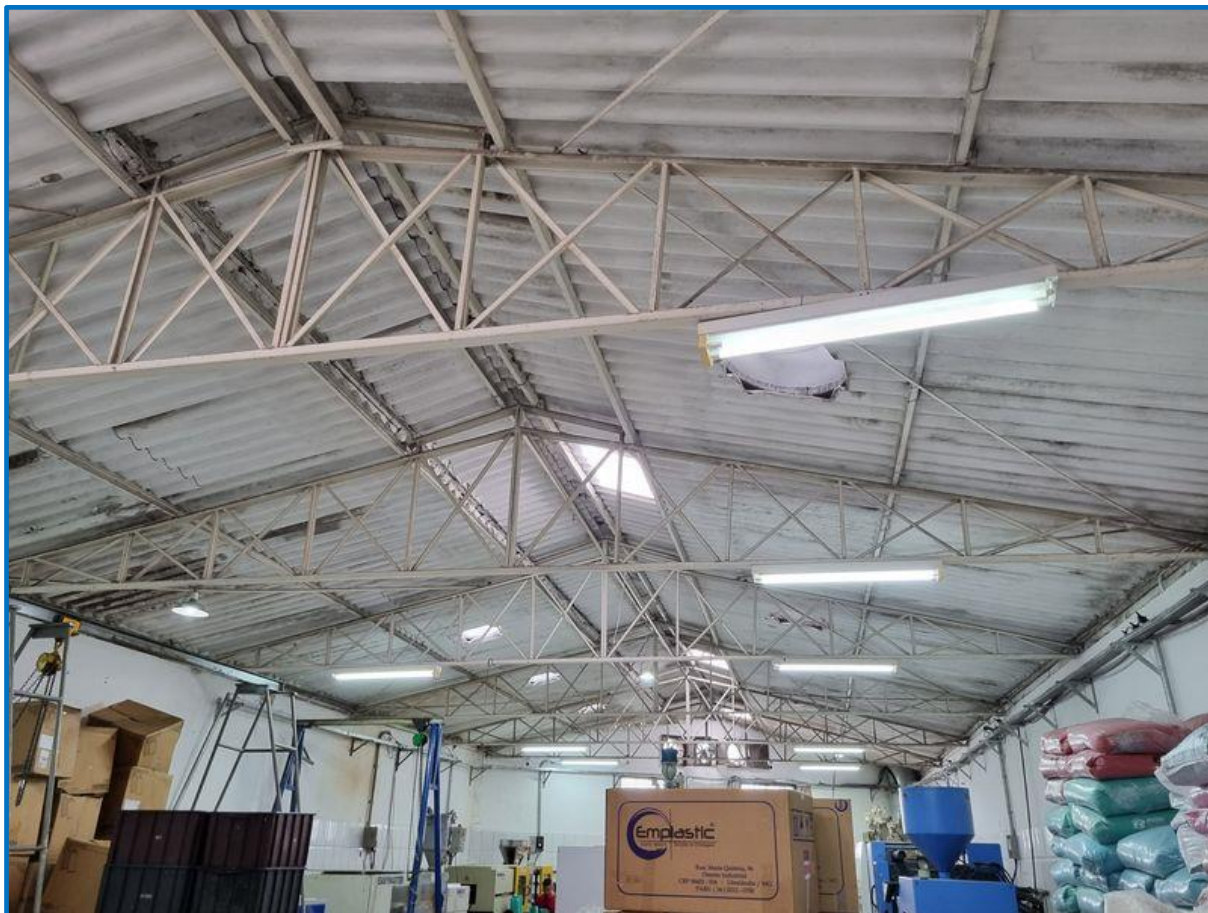
Foto 45 - Vista da cobertura da “Benfeitoria 02 – Galpão”.
