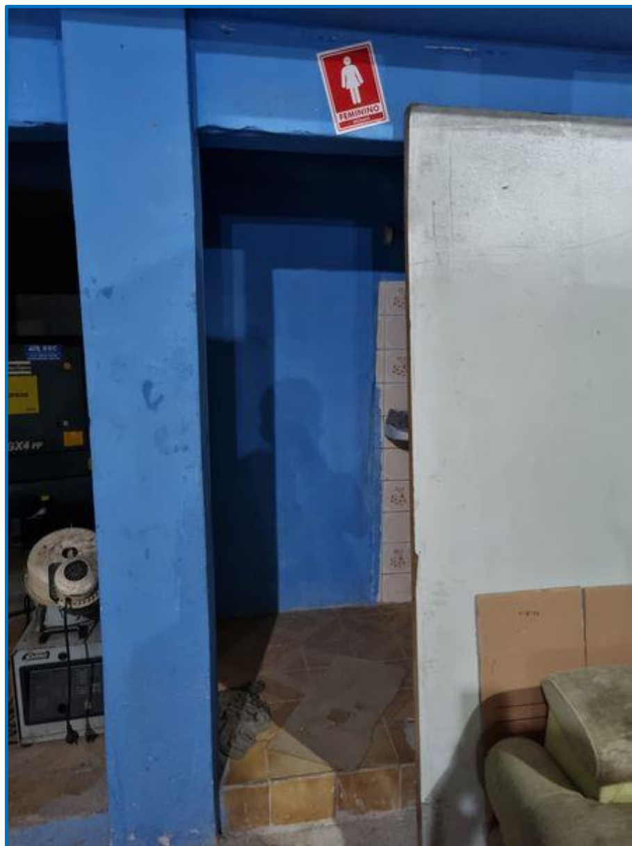
Foto 26 - Vista do vão de acesso ao banheiro feminino do subsolo ("Benfeitoria 03").
