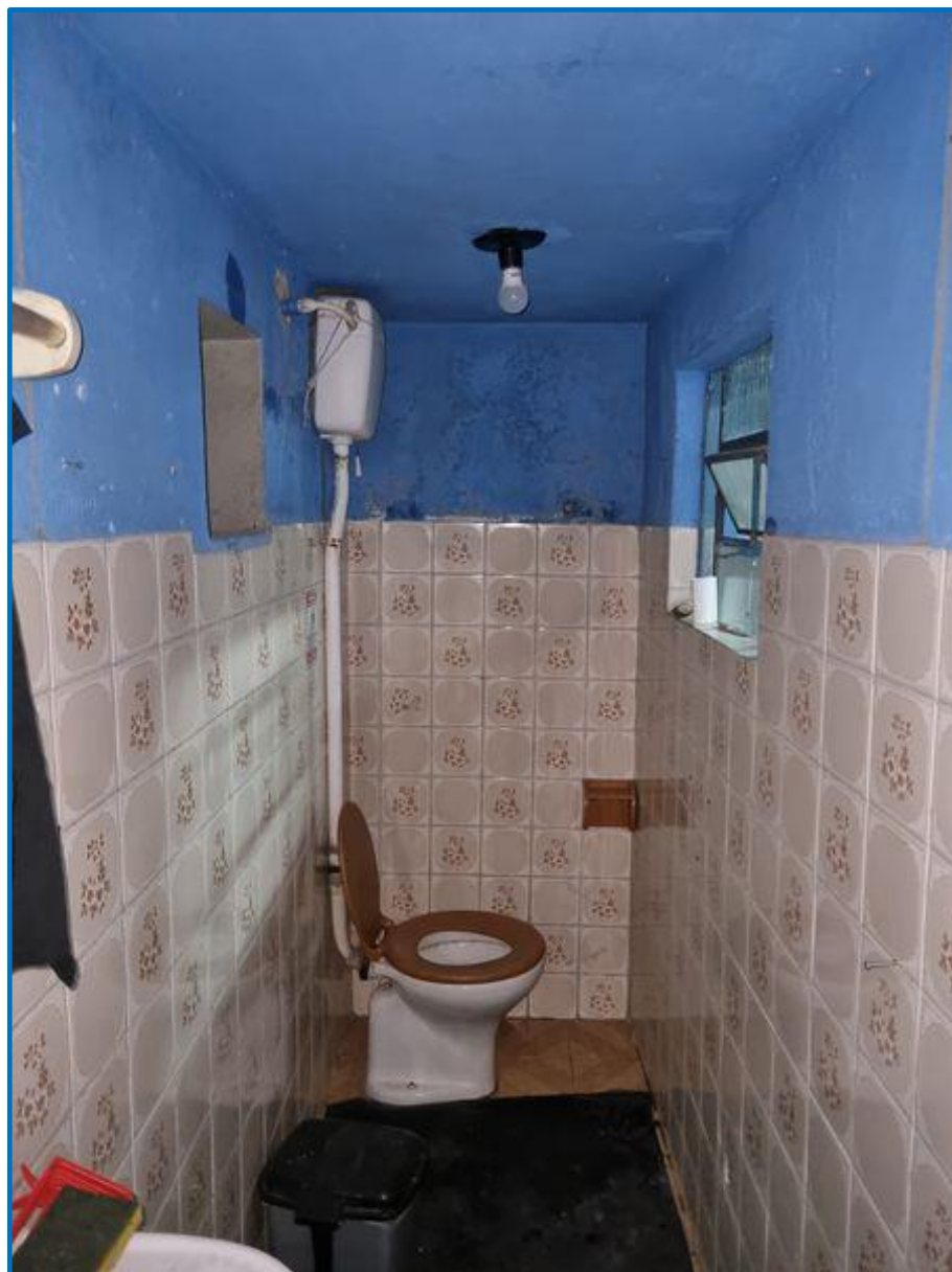
Foto 27 - Vista do interior do banheiro feminino do subsolo (“Benfeitoria 03”).
