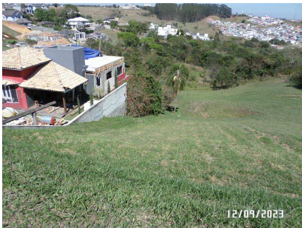
FOTO N ° 09 – VISTA PARCIAL IMÓVEL AVALIANDO – TOPOGRAFIA EM DECLIVE.
