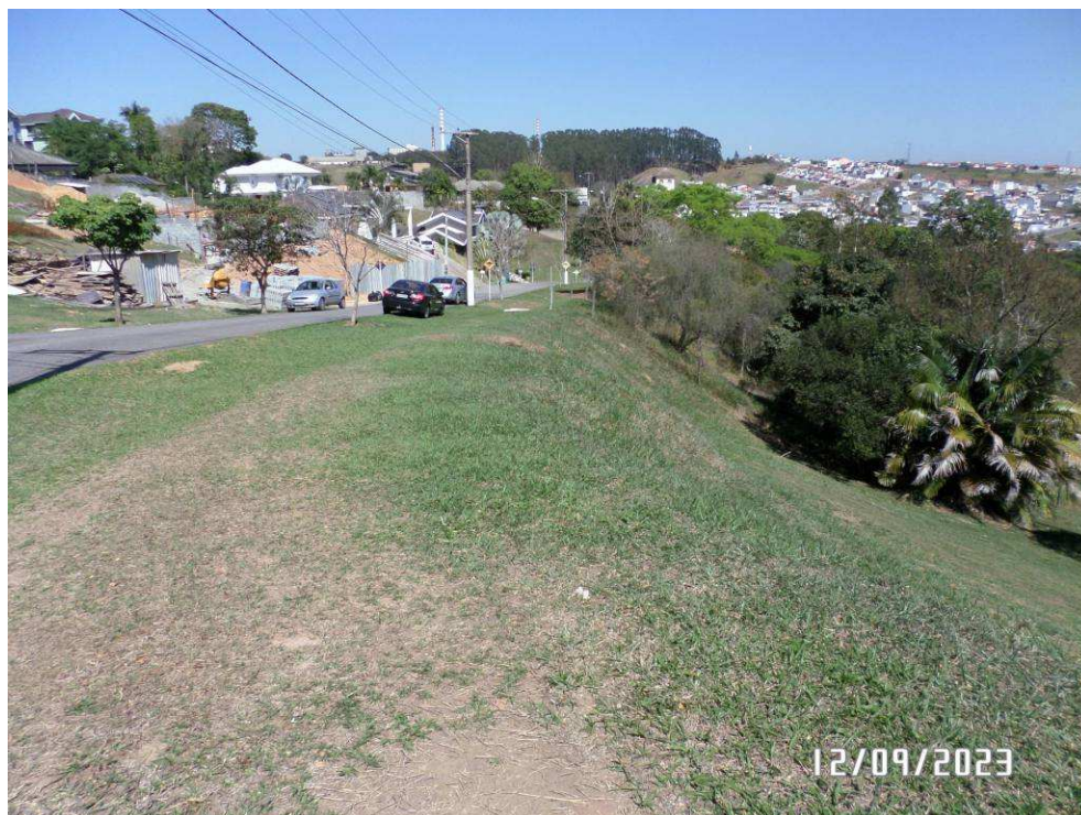
FOTO N º 04 – VISTA FRONTAL DO IMÓVEL PELA VIA PÚBLICA.
