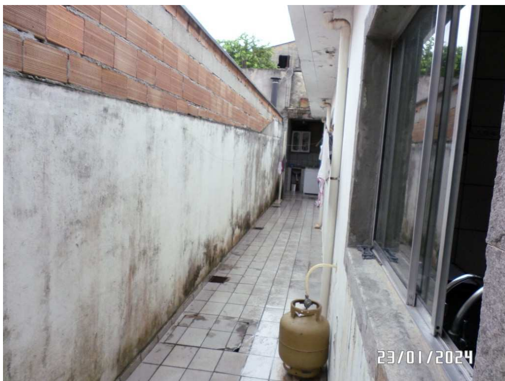
FOTO N º 12 – VISTA PARCIAL DO IMÓVEL AVALIANDO – CORREDOR EXTERNO DESCOBERTO.
