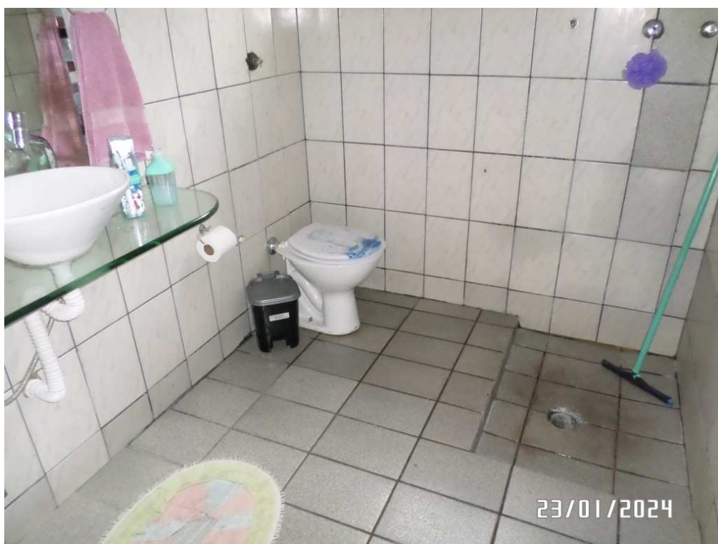
FOTO N º 09 – VISTA PARCIAL DO IMÓVEL AVALIANDO – BANHEIRO SOCIAL.
