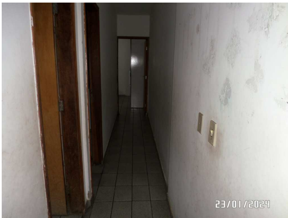
FOTO N ° 08 – VISTA PARCIAL DO IMÓVEL AVALIANDO – CORREDOR INTERNO.
