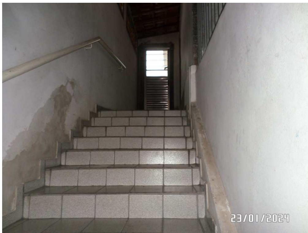
FOTO N º 04 – VISTA PARCIAL DO IMÓVEL AVALIANDO – CORREDOR LATERAL COBERTO - ESCADA.
