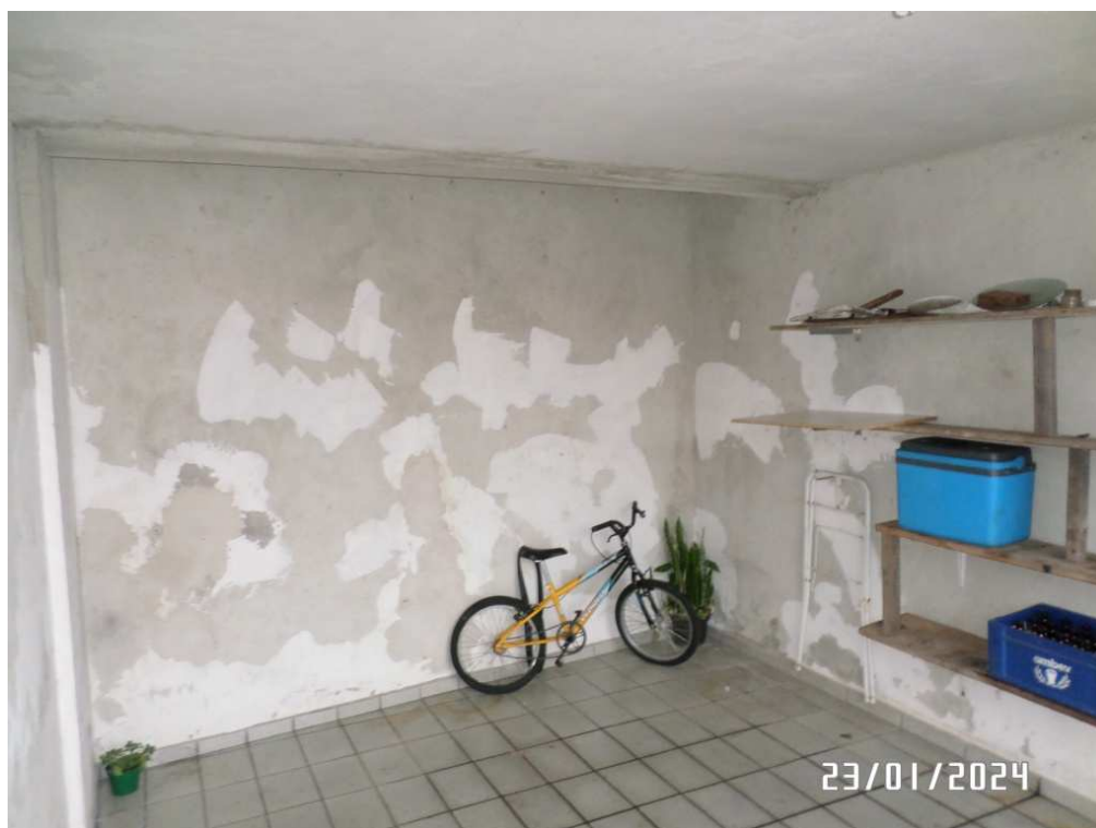
FOTO N º 03 – VISTA PARCIAL DO IMÓVEL AVALIANDO - GARAGEM.
