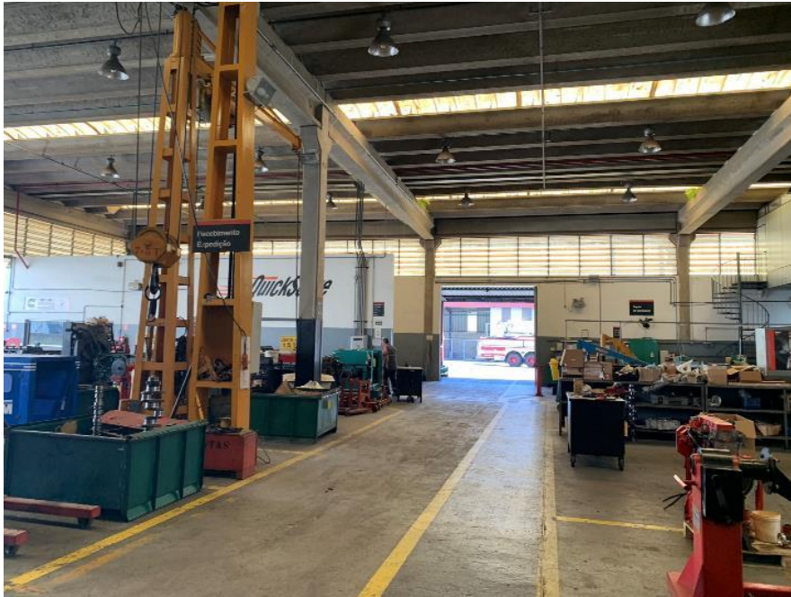
Foto 17 - Aspecto interno do Bloco A no pavimento térreo
