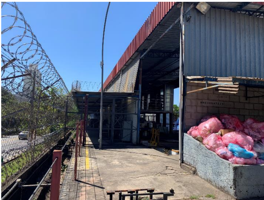
Foto 44 – Vista externa do Bloco B
