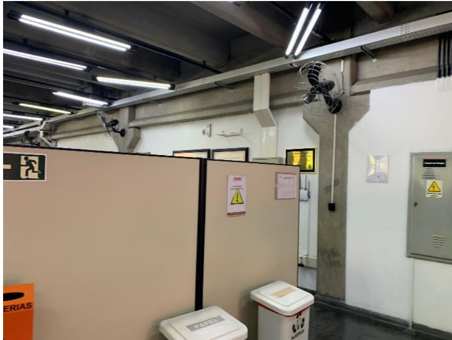
Foto 7 - Aspecto interno do Bloco A no pavimento térreo
