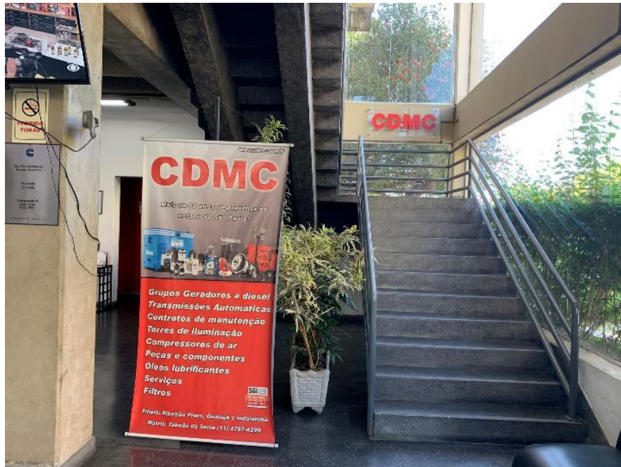
Foto 11 - Aspecto interno do Bloco A no pavimento térreo
