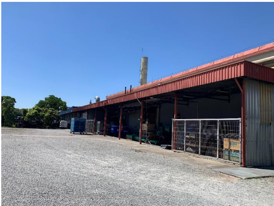
Foto 48 - Vista do Bloco A
