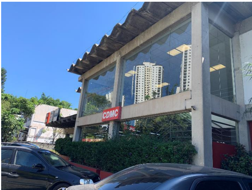
Foto 64 – Detalhe da fachada
