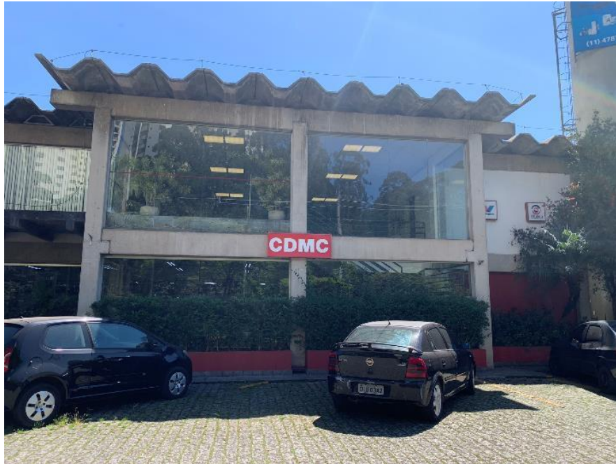
Foto 59 – Vista da fachada
