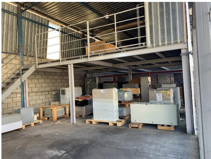
Foto 38 - Aspecto interno do Bloco B
