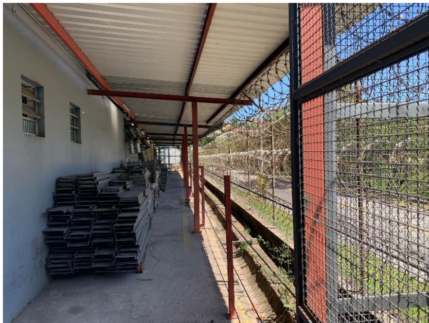
Foto 34 - Vista do Bloco B
