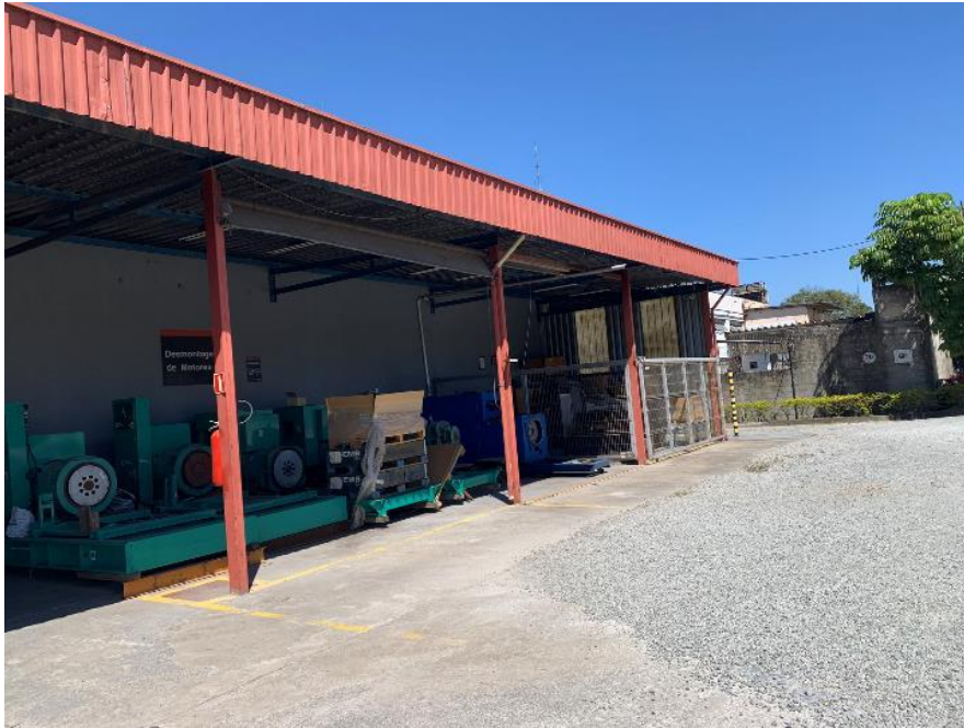
Foto 23 – Vista externa Bloco A
