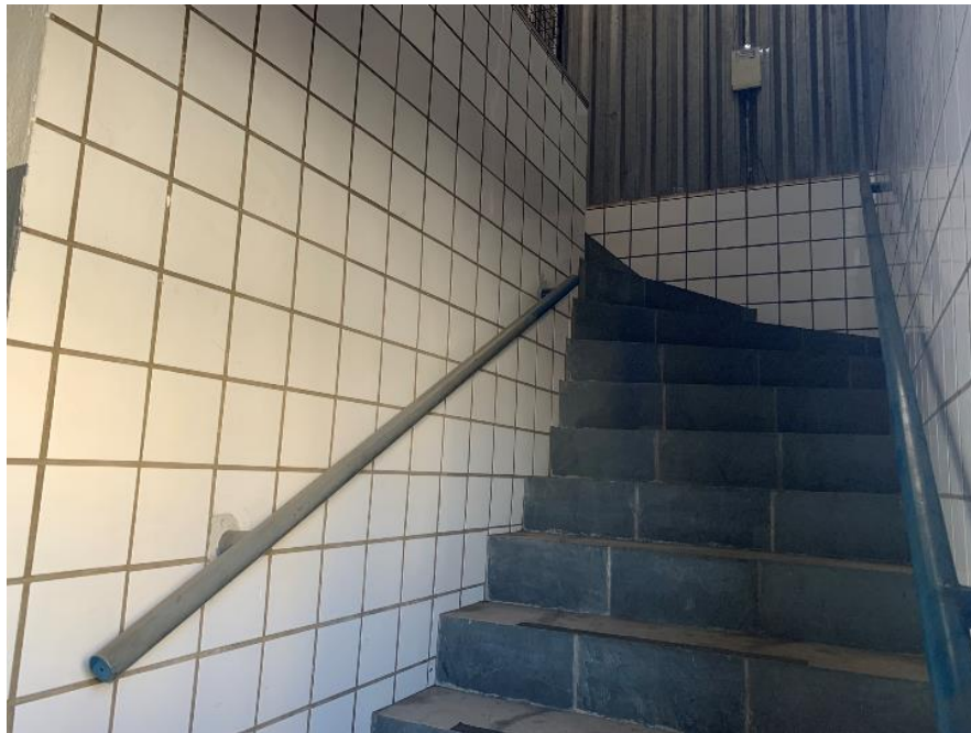
Foto 35 – Aspecto interno do Bloco B
