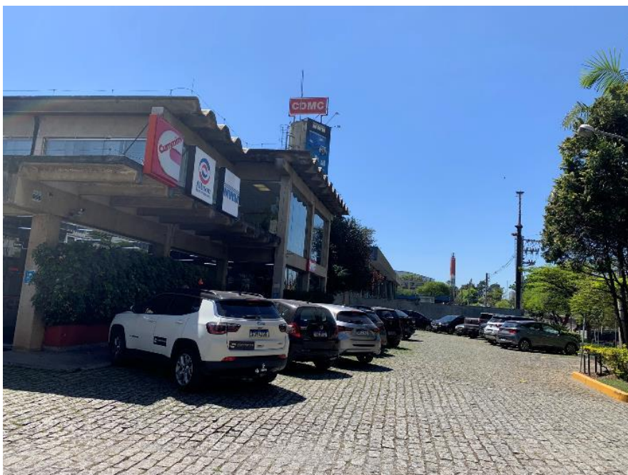
Foto 56 – Vista da fachada do imóvel
