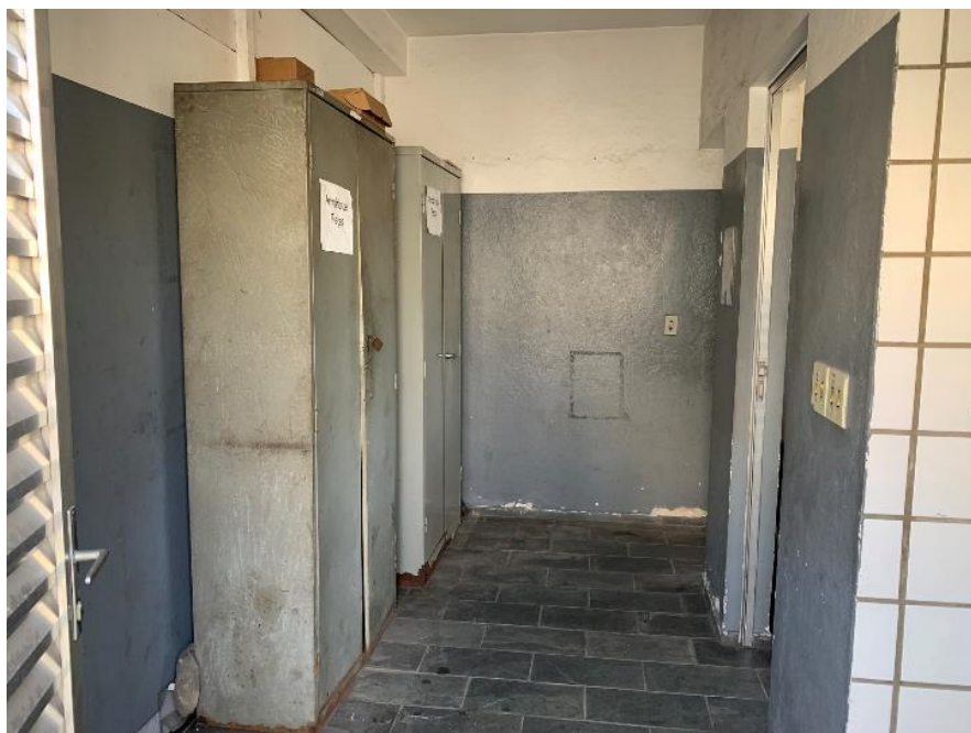
Foto 36 – Aspecto interno do Bloco B
