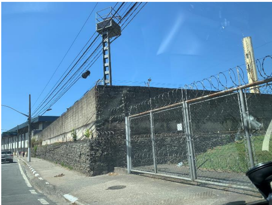
Foto 82 – Entrada do imóvel pela Avenida Armando de Andrade
