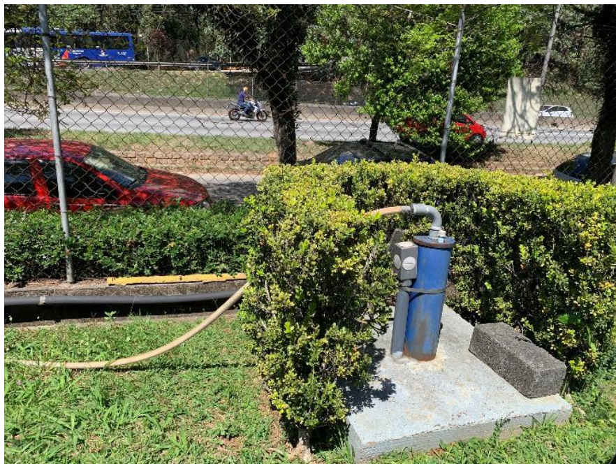
Foto 60 – Detalhe do poço do imóvel
