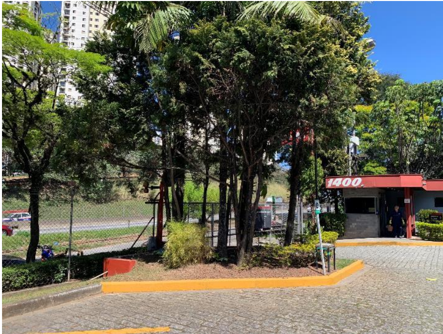
Foto 65 – Vista da entrada e da identificação numérica do imóvel
