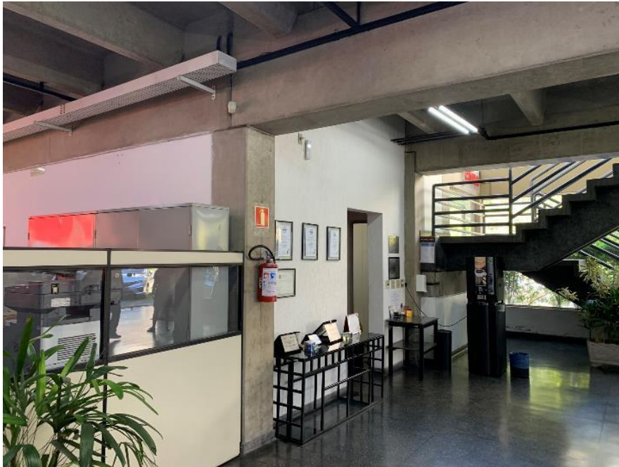
Foto 3 - Aspecto interno do Bloco A no pavimento térreo
