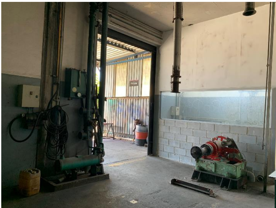
Foto 22 - Aspecto interno do Bloco A no pavimento térreo
