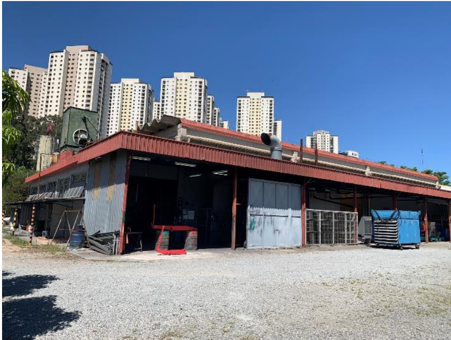
Foto 29 - Vista do Bloco B
