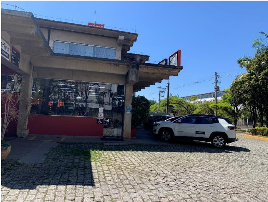
Foto 55 – Aspecto da fachada do imóvel
