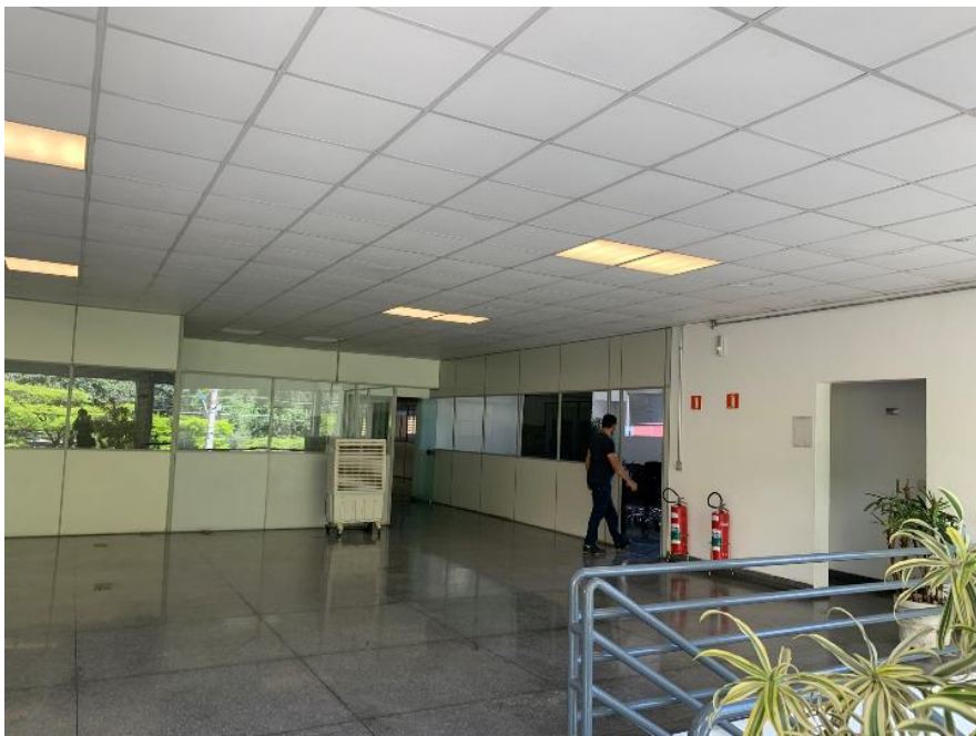
Foto 68 - Aspecto do pavimento superior do Bloco A
