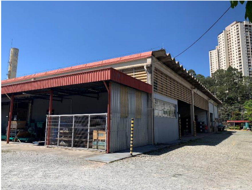
Foto 47 – Vista do Bloco A
