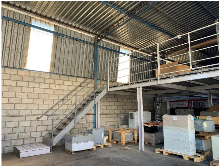
Foto 37 - Aspecto interno do Bloco B
