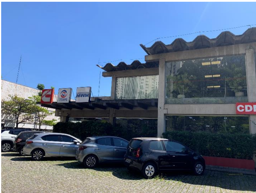
Foto 58 – Vista da fachada
