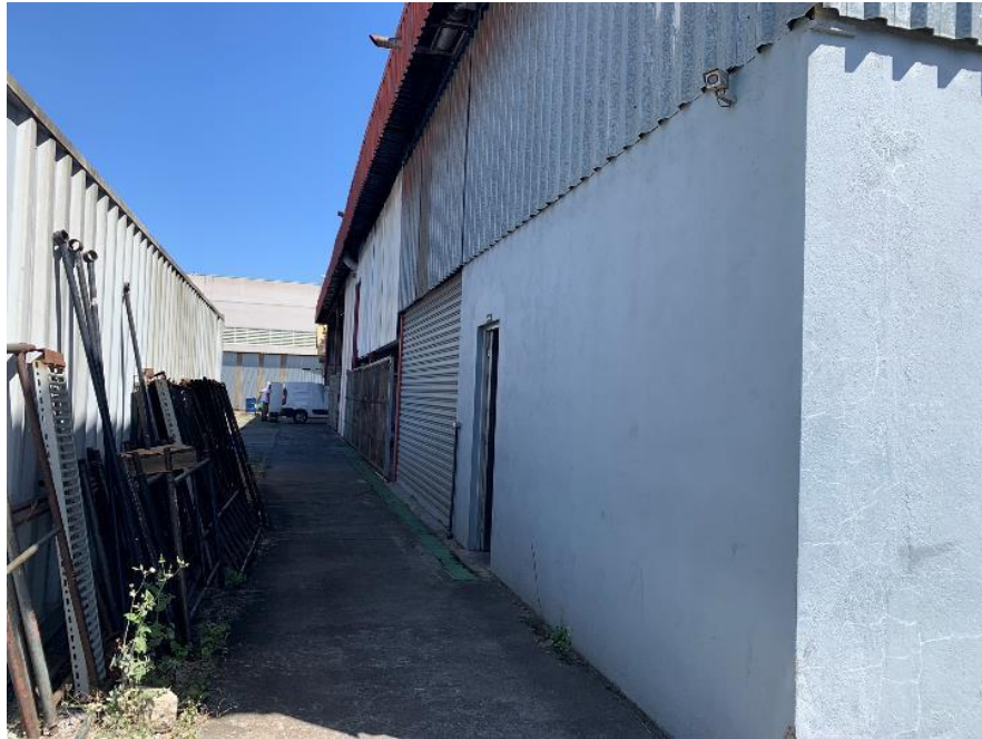
Foto 33 - Vista do Bloco B
