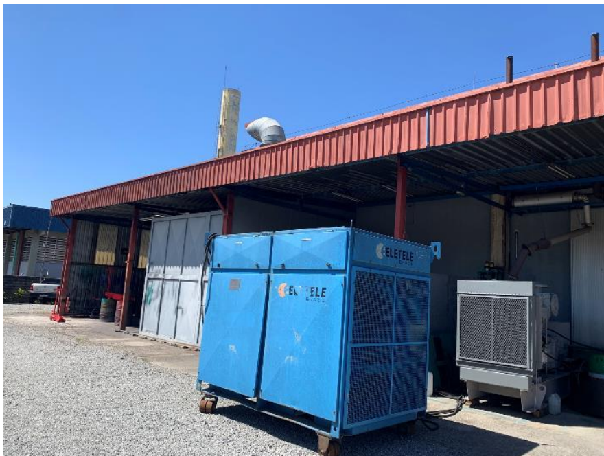
Foto 24 - Vista externa Bloco A
