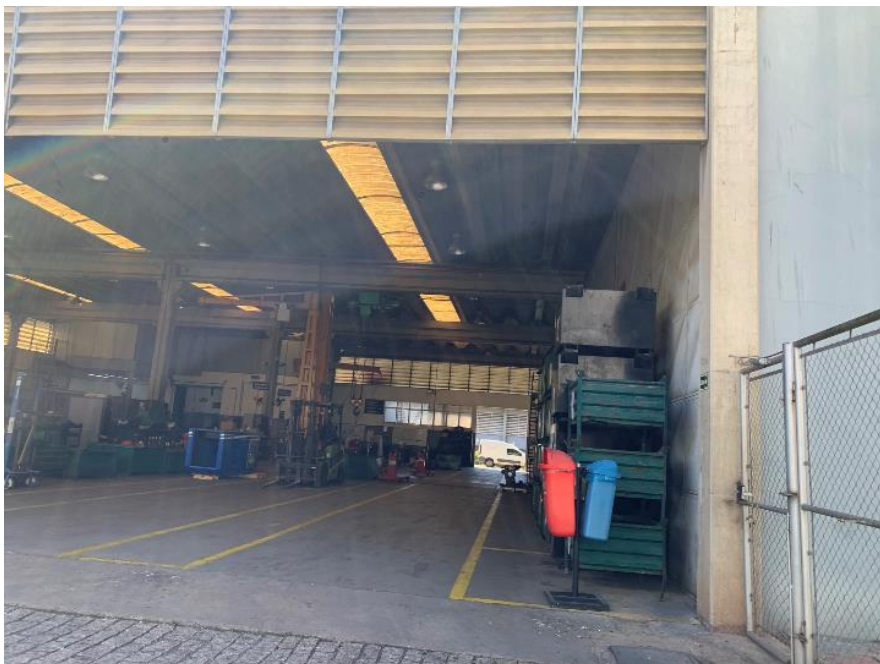
Foto 52 - Vista do Bloco A
