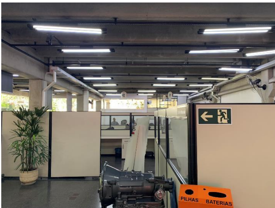
Foto 6 - Aspecto interno do Bloco A no pavimento térreo
