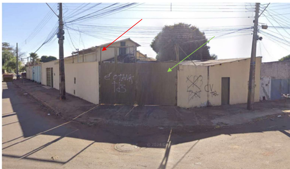
Imagem 01 - Fachada do imóvel objeto da lide, sendo a casa principal identificada pela seta vermelha, e a área da oficina mecânica pela seta verde.
