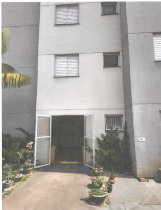
Imagem 3 - Entrada do Bloco C - Fonte: Autor
