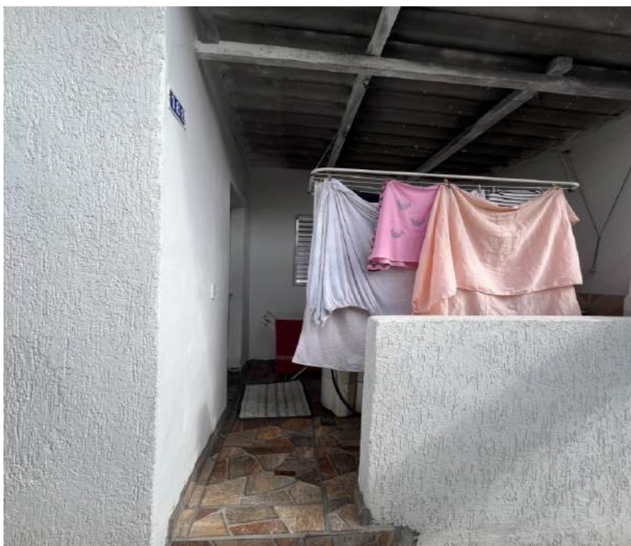
Outra lavanderia casa 01.
