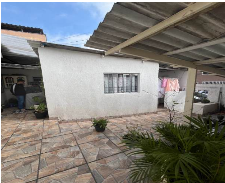
Vista da residência nº 01.
