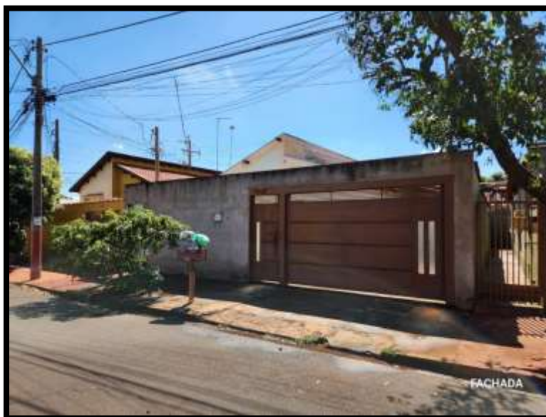
VISTAS DA FACHADA DO IMÓVEL AVALIANDO
