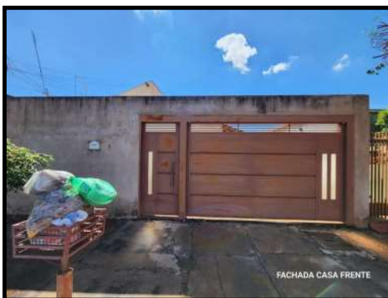
VISTA DA FACHADA ENTRADA DA RESIDÊNCIA I
