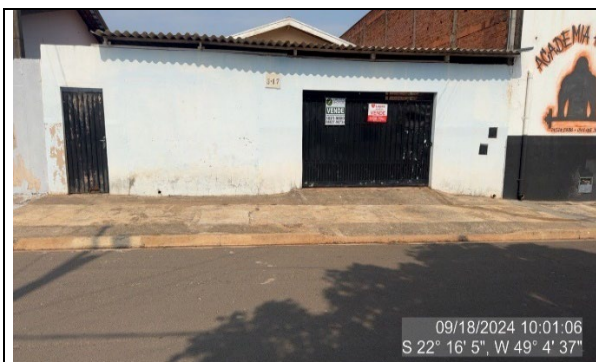
Foto 01. Vista da fachada
