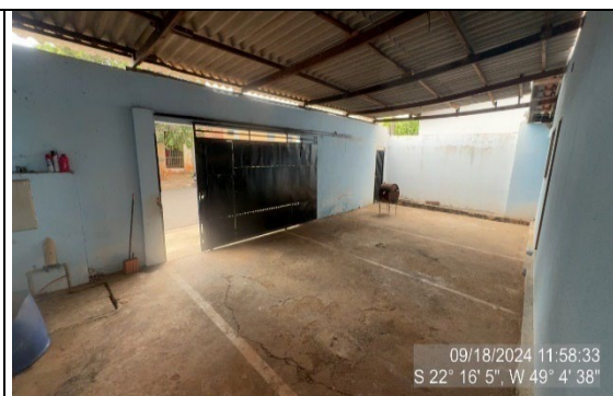
Foto 02. Vista do interior da cobertura
