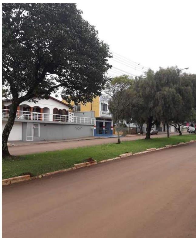
Foto 32, Avenida Brasil, fonte: Autoria própria
