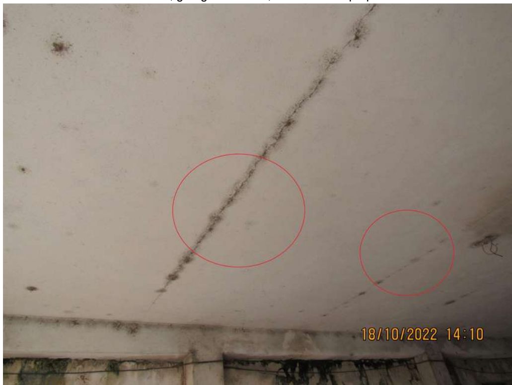
Foto 14, laje teto garagem coberta, fonte: Autoria própria
