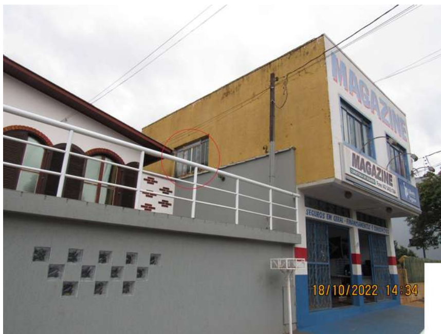
Foto 31, apartamento 1, detalhe da janela sem afastamento de 1,5m da divisa, fonte: Autoria própria
