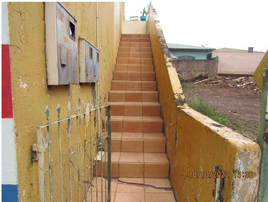
Foto 11, escada acesso apartamento, fonte: Autoria própria
