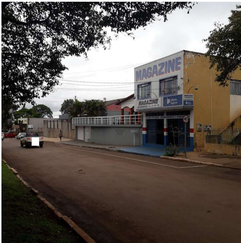
Foto 33, Avenida Brasil, fonte: Autoria própria
