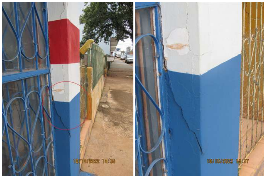
Foto 30, sala comercial 1, Obs: detalhe pilar, fonte: Autoria própria
