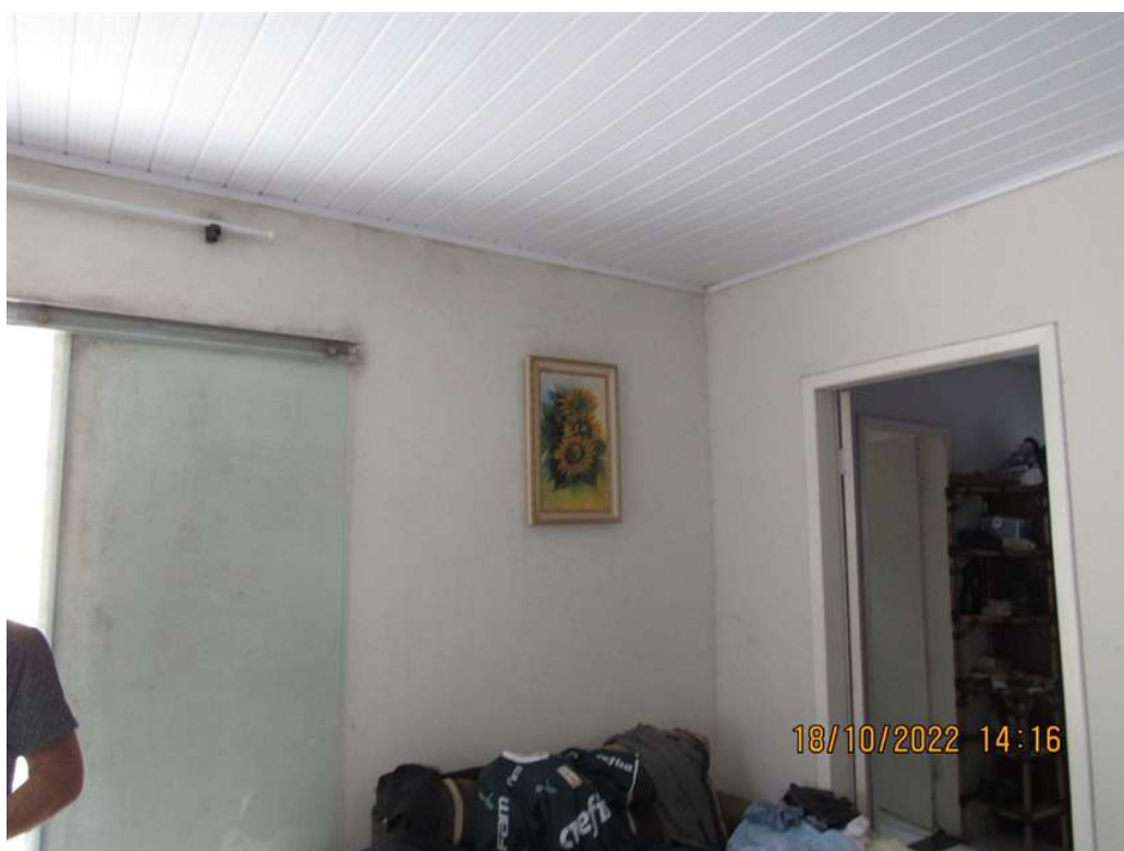
Foto 20, cozinha/sala/porta de vidro, porta acesso suíte, residência 1, fonte: Autoria própria nedioarquiteto@gmail.com - Perito Judicial - (46) 99976 50 67 (46) 3225 8107 Pato Branco – Paraná.
