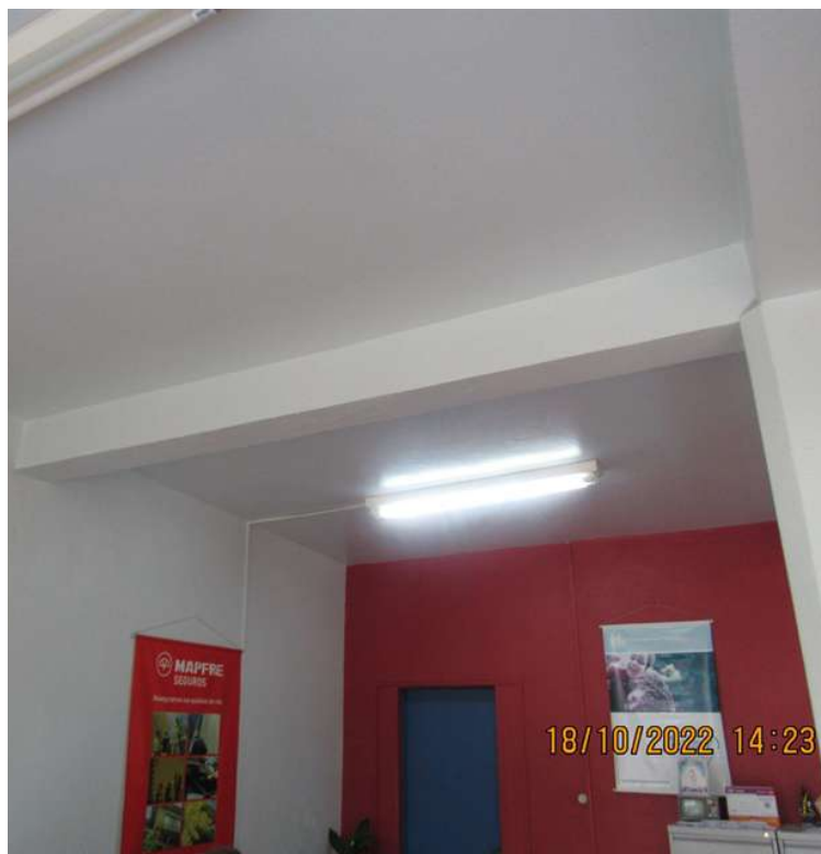
Foto 25, sala comercial 1, fonte: Autoria própria
