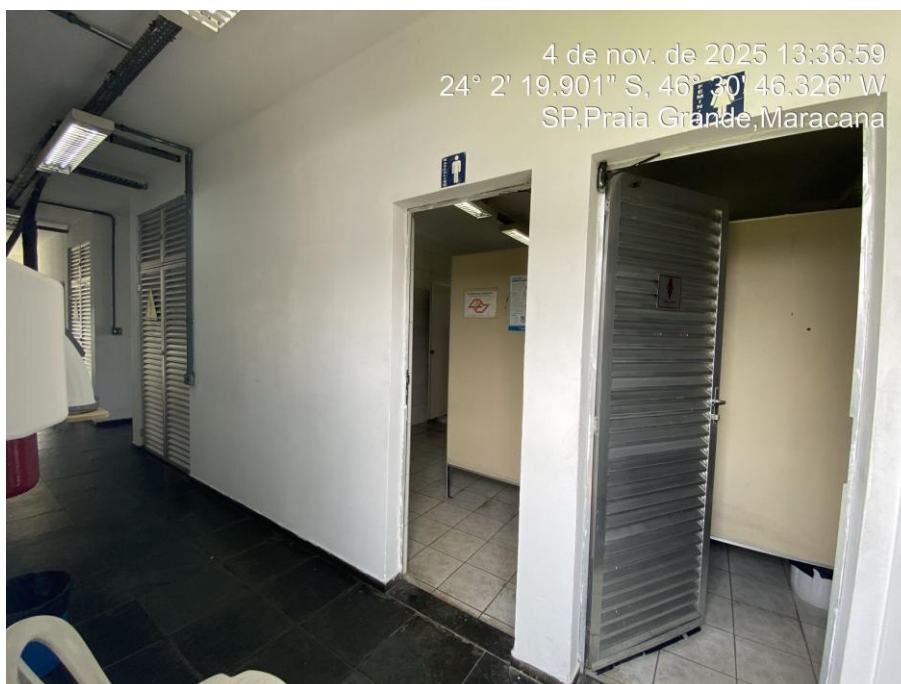
Foto 9: Vista da entrada dos vestiários.
