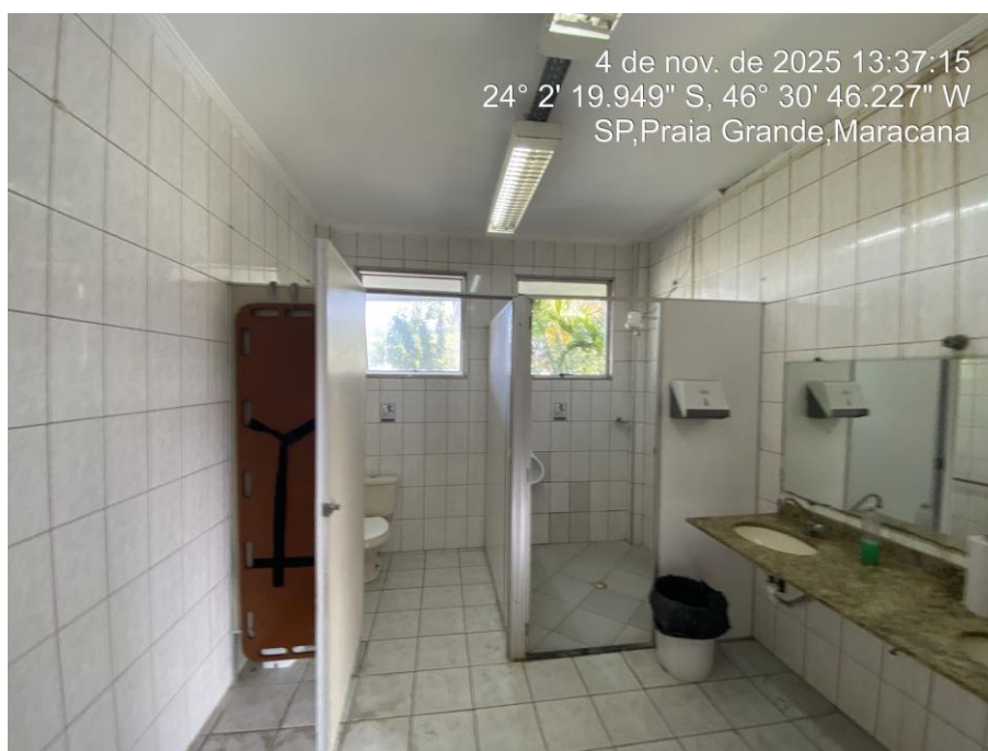
Foto 7: Vista de um dos vestiários
