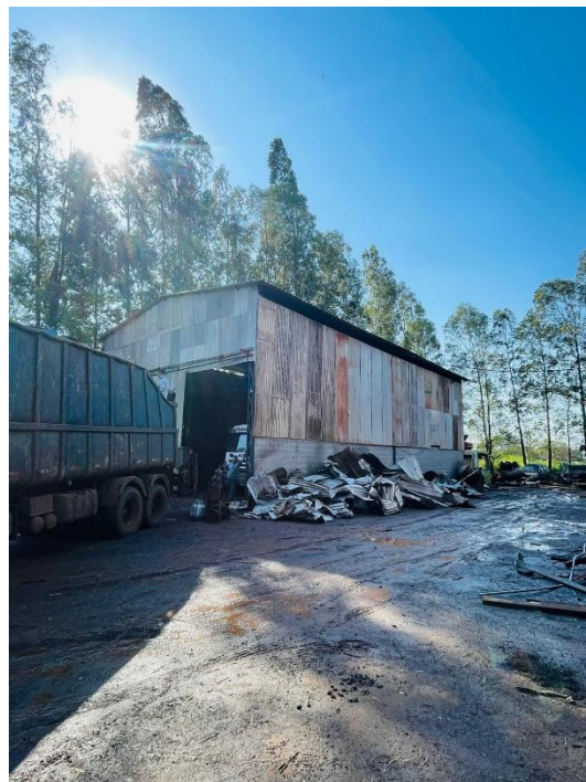
Galpão com 260,00 m 2
