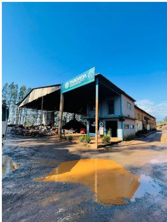
Área Principal – Galpão com 880,00 m 2
