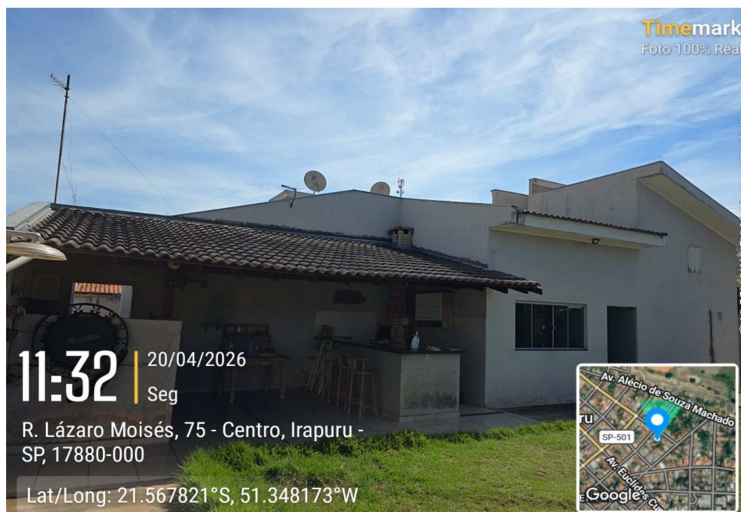
Vista lateral da edificação
