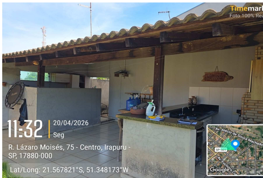
Varanda nos fundos/lateral do imóvel
