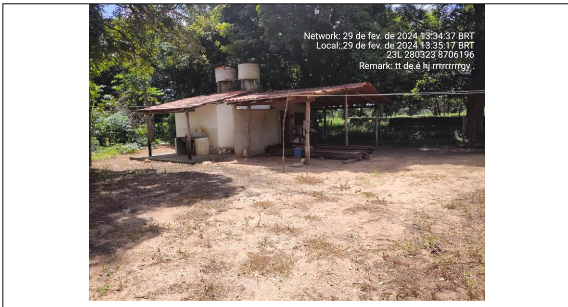
Fotografia 12: Vista da sede da Fazenda São Pedro.
