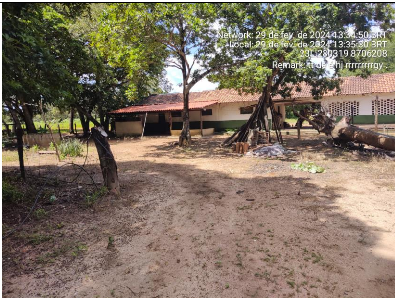
Fotografia 09: Vista da sede da Fazenda São Pedro.
