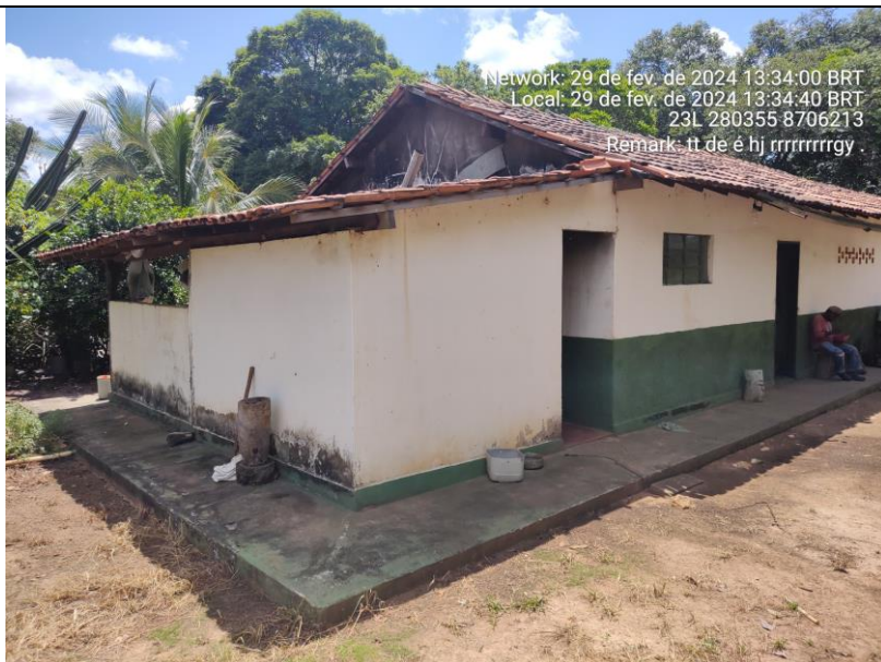
Fotografia 10: Vista da sede da Fazenda São Pedro.
