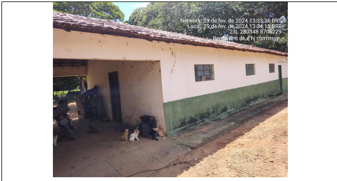
Fotografia 11: Vista da sede da Fazenda São Pedro.
