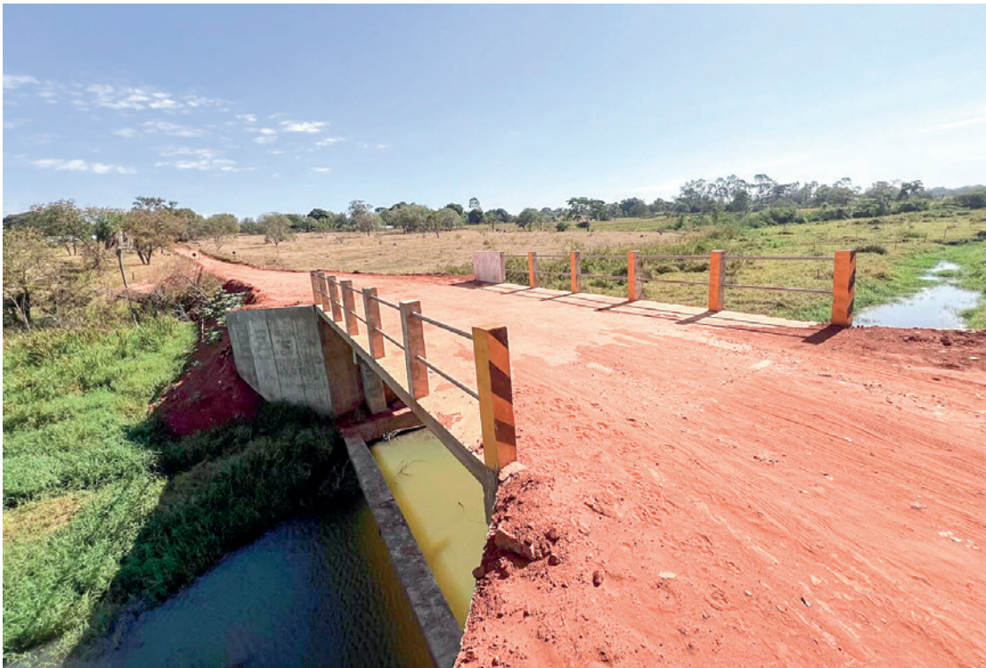
A ponte de concreto João Preto foi construída no Córrego Ribeirão Lagoa
