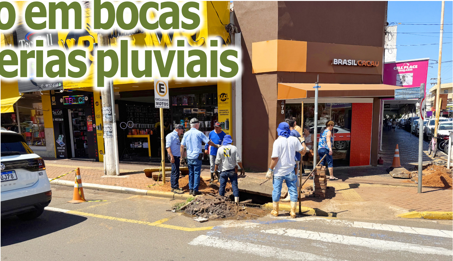
Desobstrução em bocas de lobo 01, 02 e 03: Os trabalhos iniciados na manhã dessa segunda-feira (11) foram realizados no cruzamento da Avenida Francisco Jales com a rua 10 e se estenderão para outras áreas
