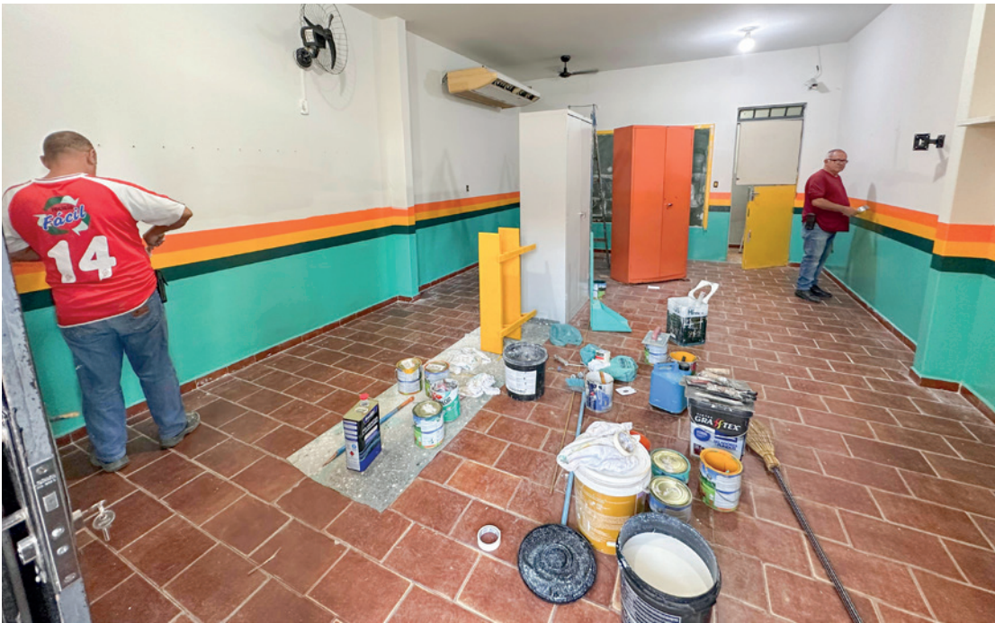
A EMEIdercílio de Carvalho está recebendo pintura das áreas externas e internas da escola
