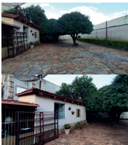
Figura 25- Vista externa da situação atual do Imóvel.
