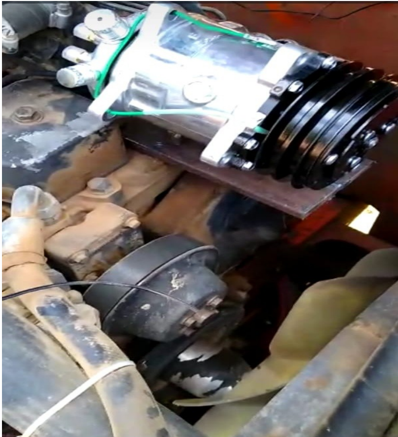
Figura 12: Construção do suporte do compressor do ar condicionado. Fonte: Elaborada pelo autor.
