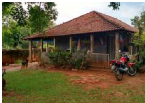
Vista casa de caseiro – Imóvel 1
