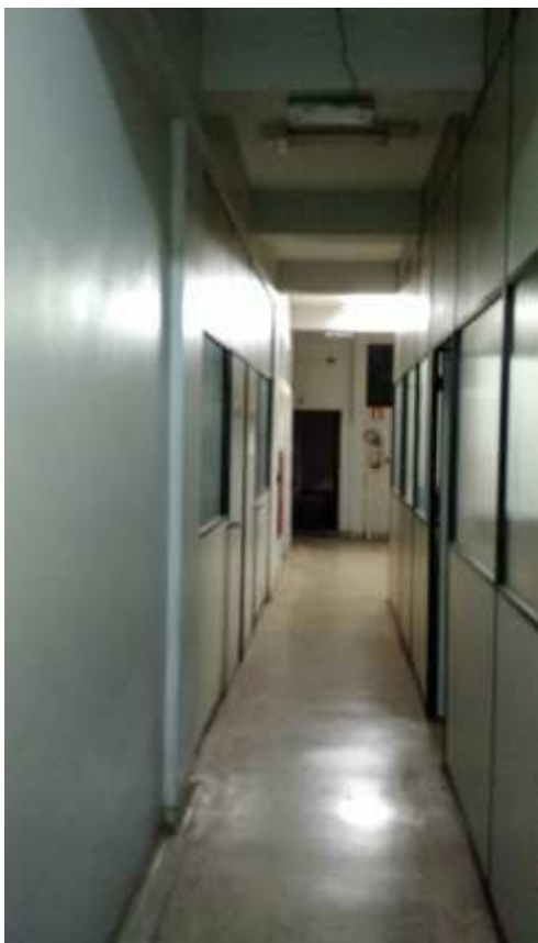
Corredor de acesso à escritórios
