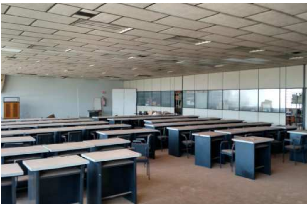
Vista parcial salão de convenções.
