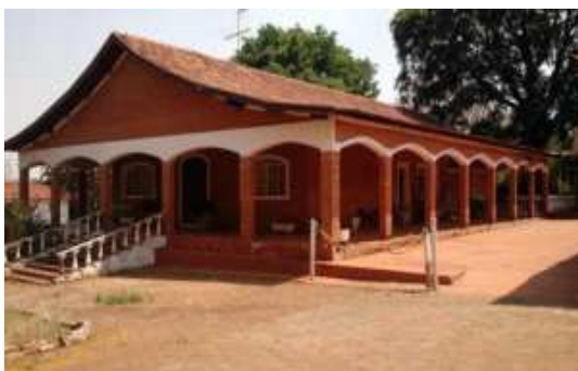
Vista da casa principal (Imóvel 1)
