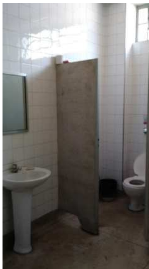
Banheiro piso inferior
