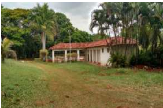
Vista dos vestiários Imóvel 1
