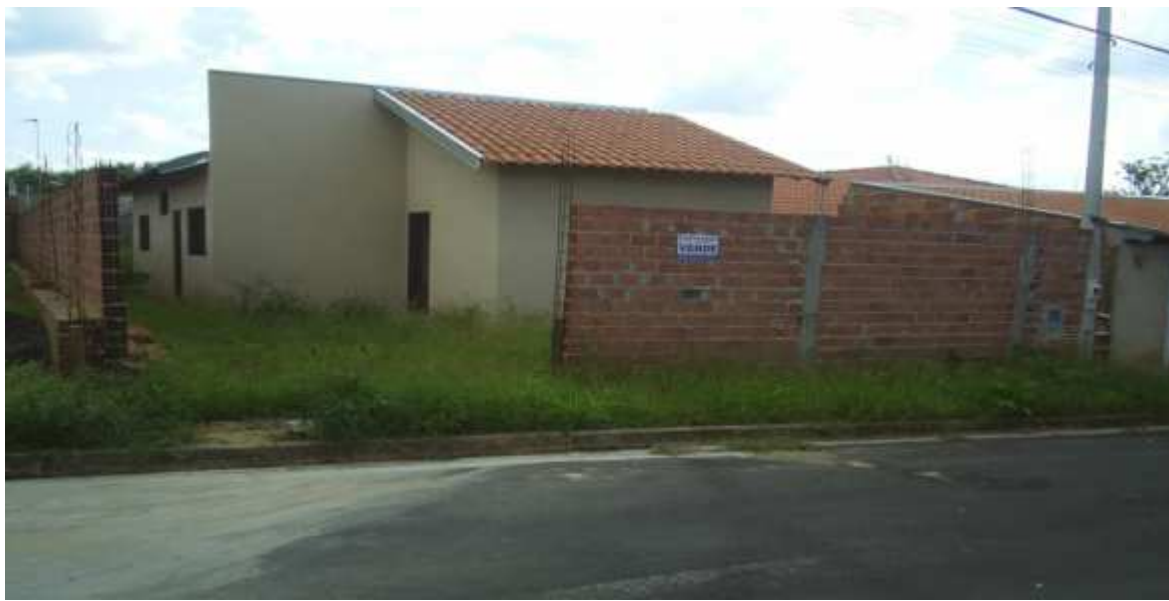
Foto N° 01: Mostrando a frente do imóvel.
