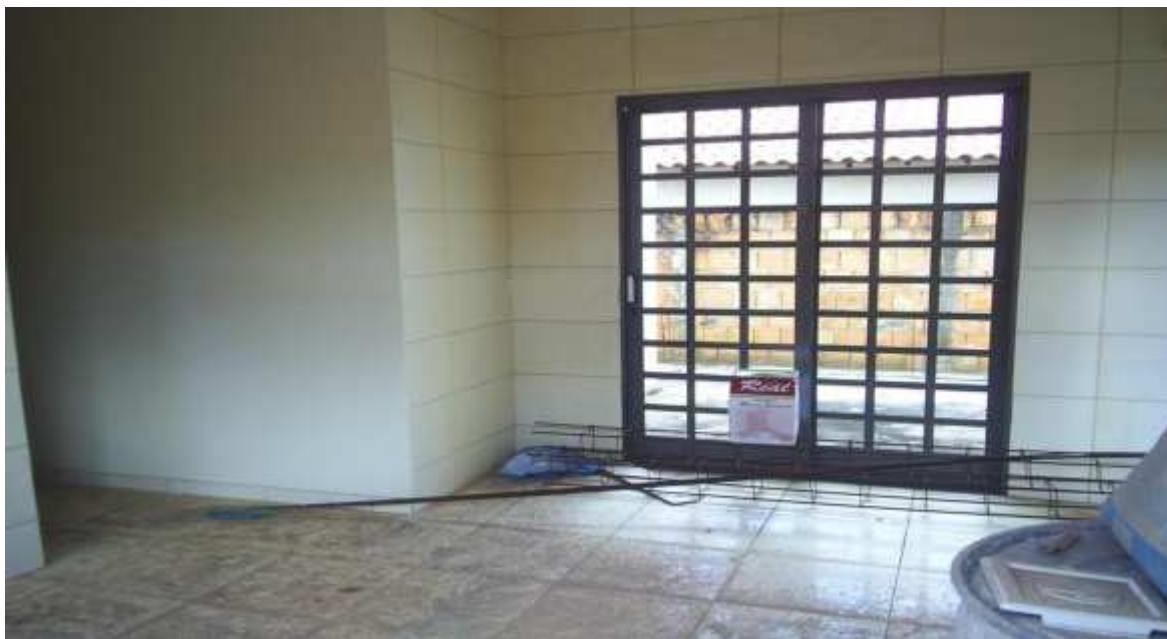
Foto N° 03: Mostrando uma parte da copa-cozinha
