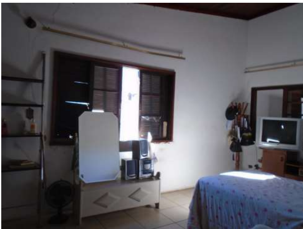
Foto 10: Dormitórios . piso cerâmico, esquadrias e forro de madeira,
