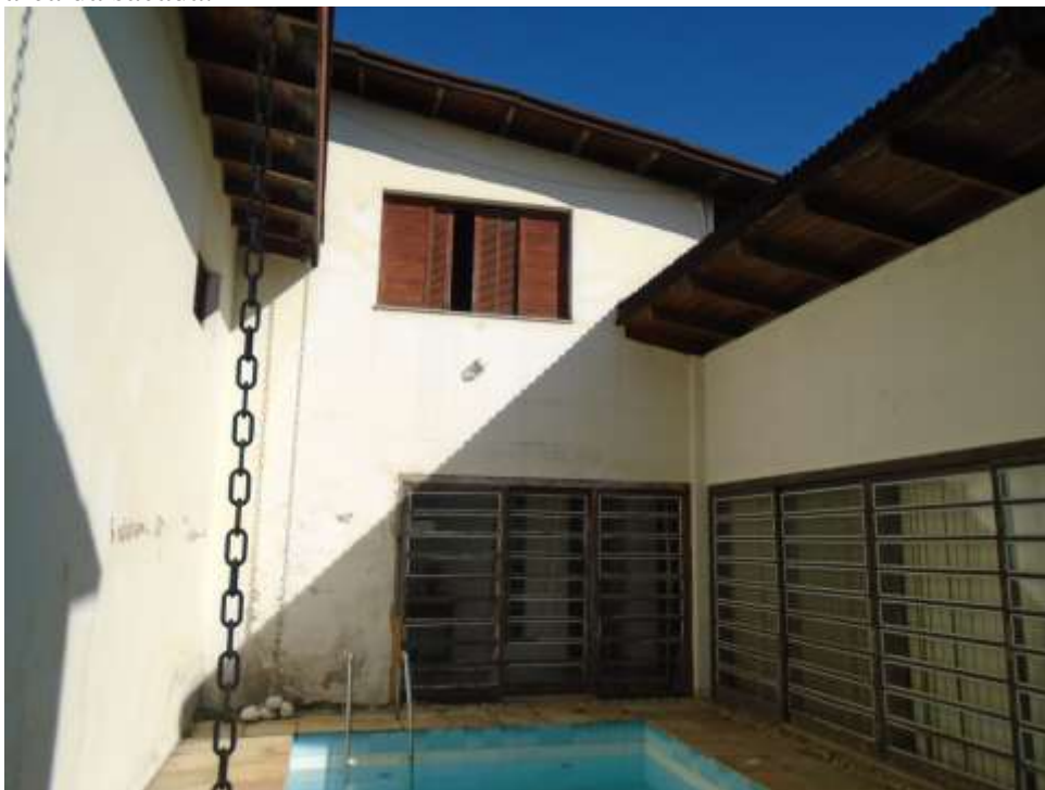
Foto 13: Ilustra a área da piscina que tem acesso pela sala jantar e área gourmet além da área da sacada.
