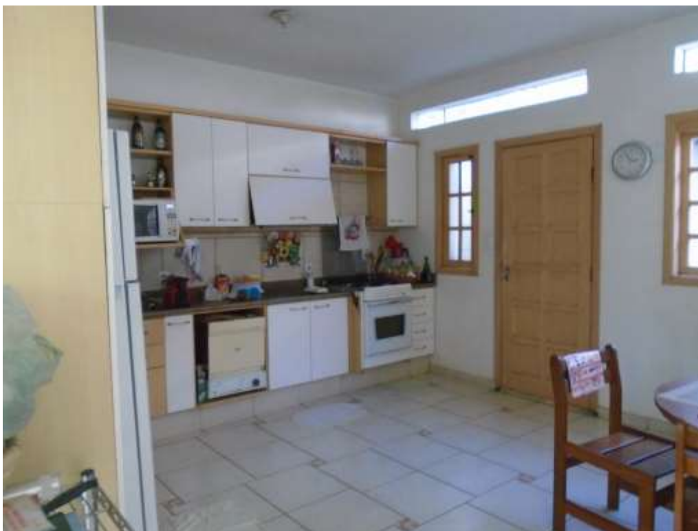
Foto 6: Cozinha, piso cerâmico, esquadrias e forro laje pre-moldada.
