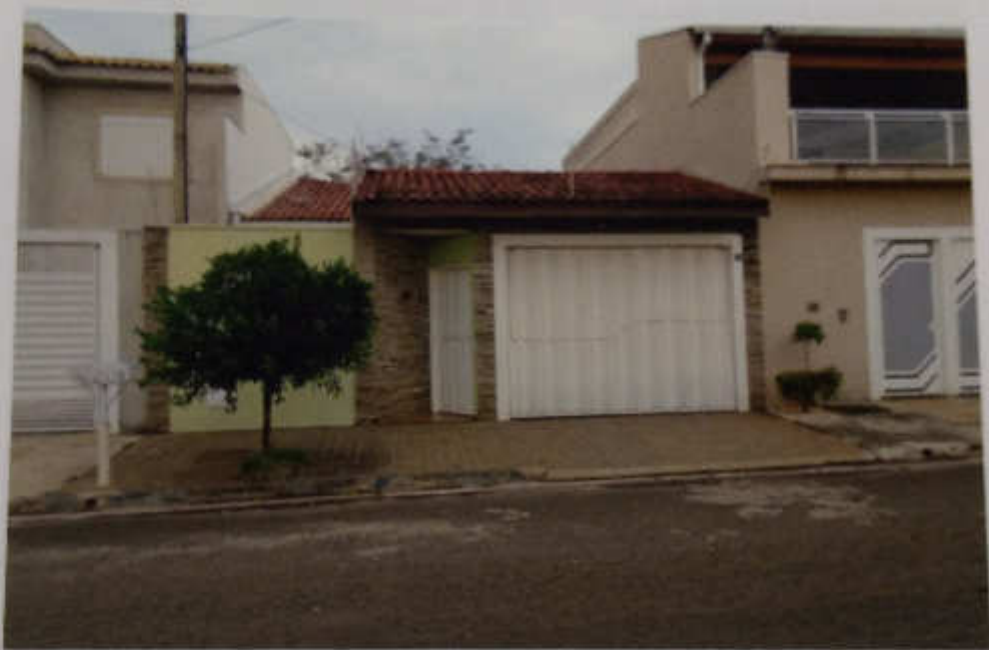
FOTO 01: MOSTRA A FRENTE DO IMÓVEL.
