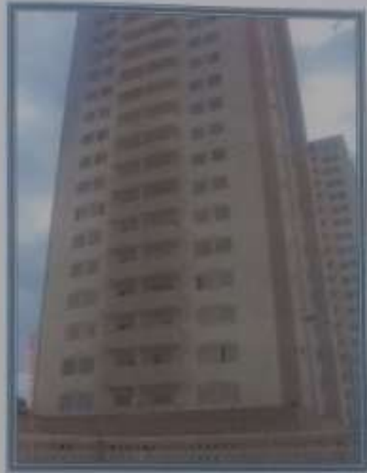
Bloco B - Edifício Rio Verde
