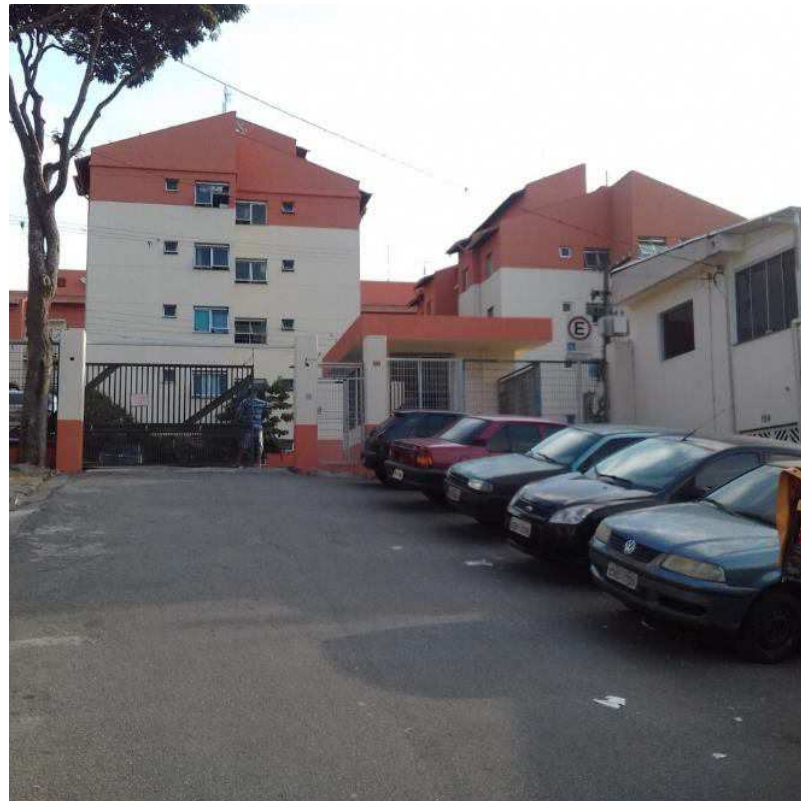
Portaria e acesso ao estacionamento
