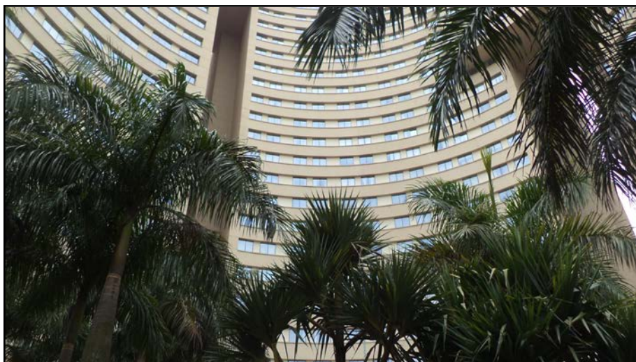
Foto 02: Vista geral do condomínio Stadium.
