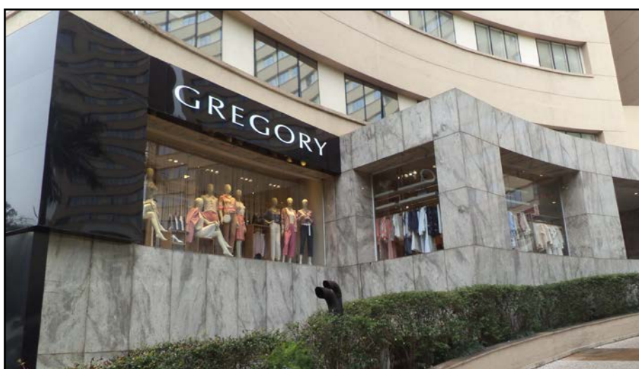
Fotos 03 e 04: Vistas parciais da Torre Comercial.
