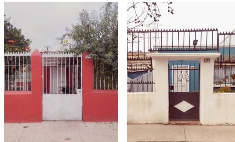
Figura 75 - 76. Fachadas de las viviendas de la Población Obreros Cristal Yungay. Fuente: Municipalidad de Quinta Normal, 2024.
