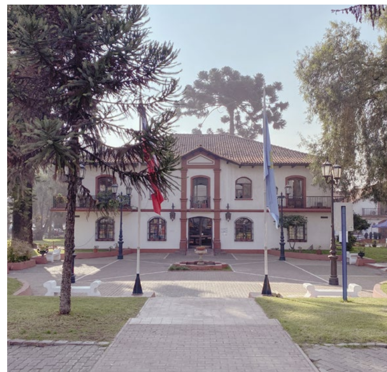
Figura 24. Fachada del Edificio Consistorial. Fuente: Municipalidad de Quinta Normal, 2024.
