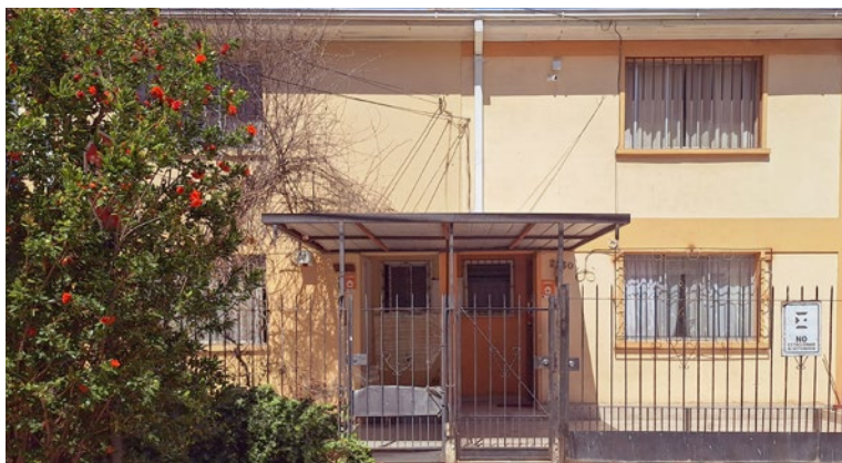
Figura 72. Fachadas de las viviendas de la Población Industrial Indus Lever. Fuente: Municipalidad de Quinta Normal, 2024.
