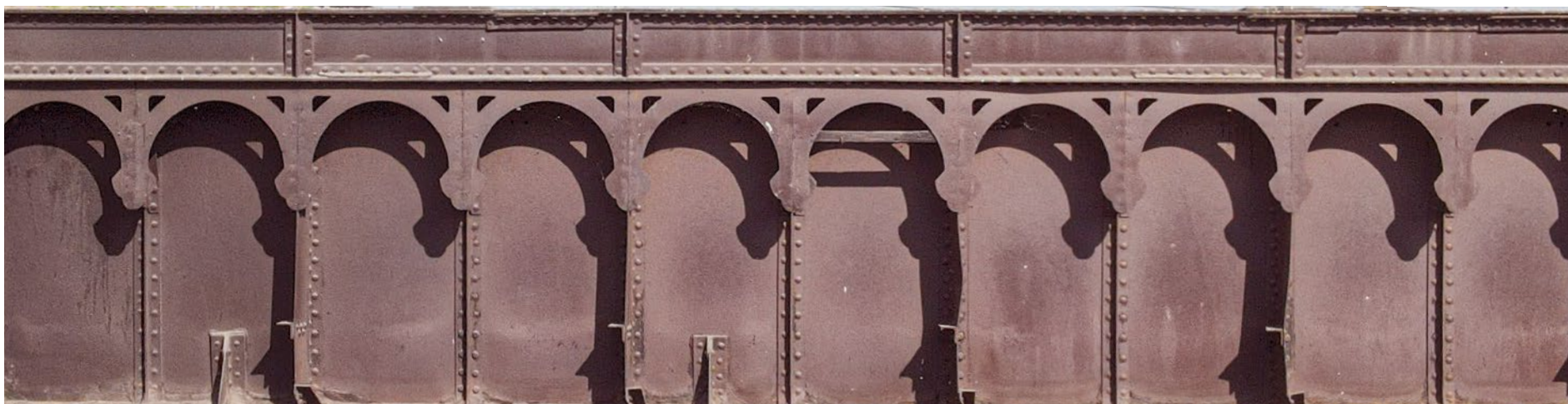
Figura 30. Detalle elevación oriente del Puente La Máquina. Fuente: Municipalidad de Quinta Normal, 2024.
