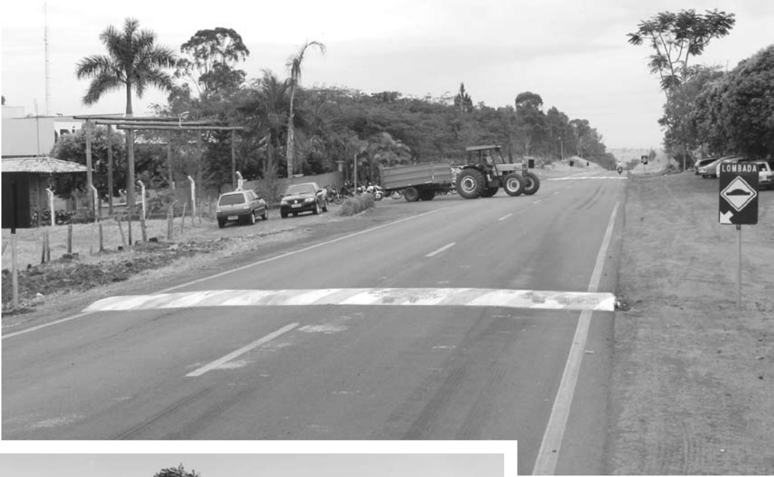
Acima e ao lado, os redutores de velocidade (lombadas), construídos nos dois sentidos, num trecho em frente ao Frigorífico Ouroeste; as ondulações transversais respeitam as normas estabelecidas pelo Conselho Nacional de Trânsito
