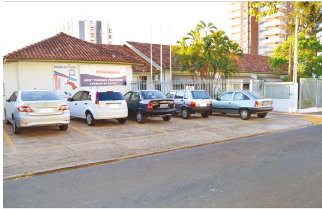
Escola “Coronel”, localizada à Avenida Milton Terra Verdi, onde as aulas serão ministradas
