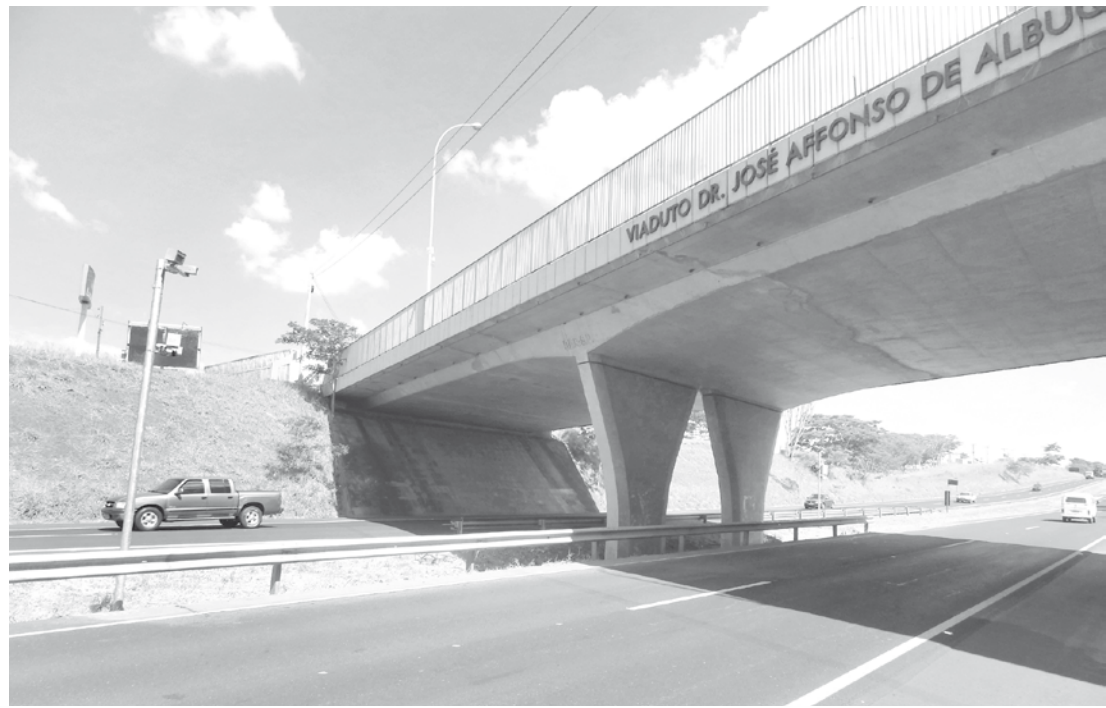
Os radares em Fernandópolis estão instalados embaixo do pontilhão que passa sobre a Euclides da Cunha
