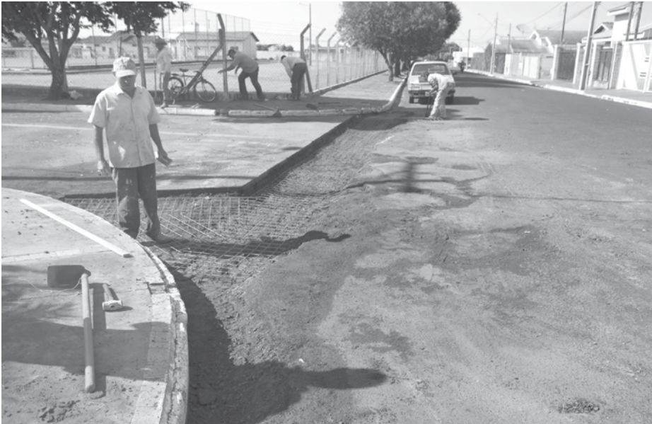
Os “sarjetões” substituem os locais com “depressão” existentes em esquinas para escoamento de águas pluviais
