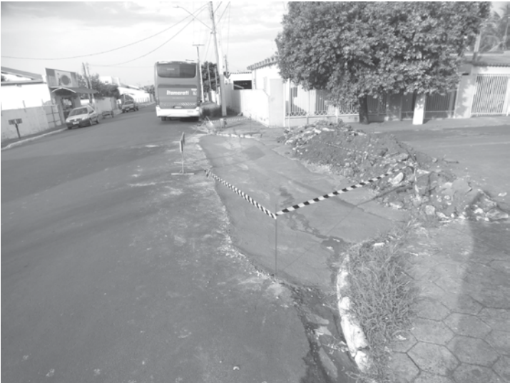
A construção dos sarjetões proporciona melhores condições aos motoristas, bem como facilita e minimiza os impactos dos veículos
