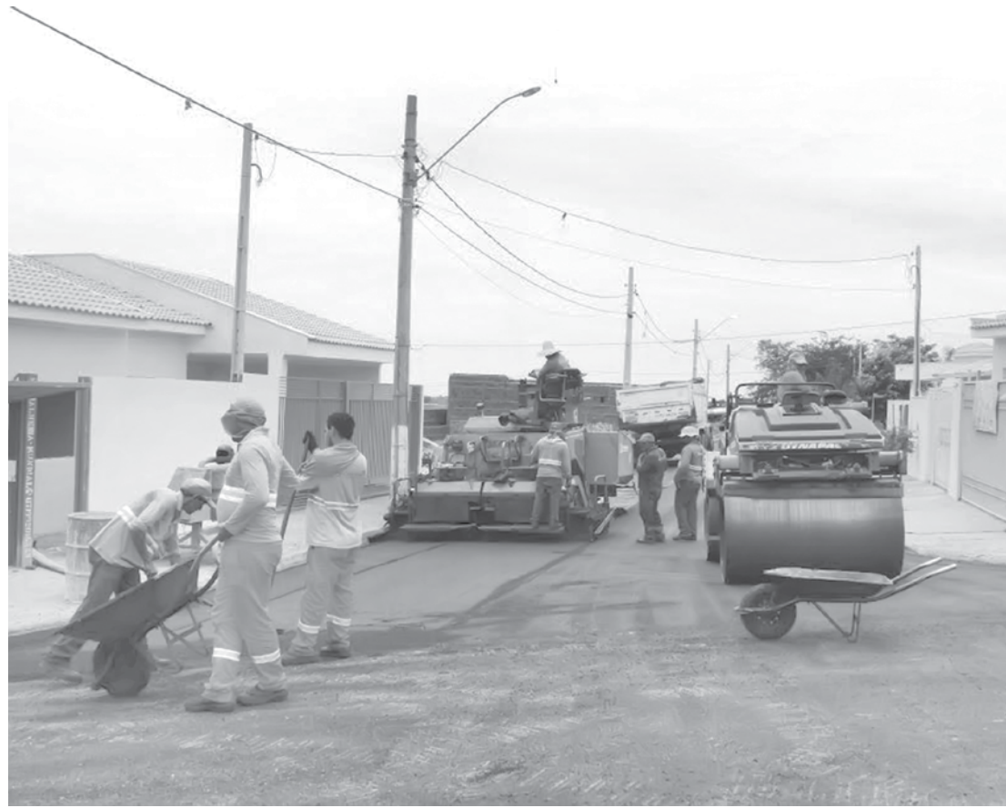
Execução de serviços na Rua Manoel Alves de Lima, no Jardim dos Ypês, em Valentim Gentil
