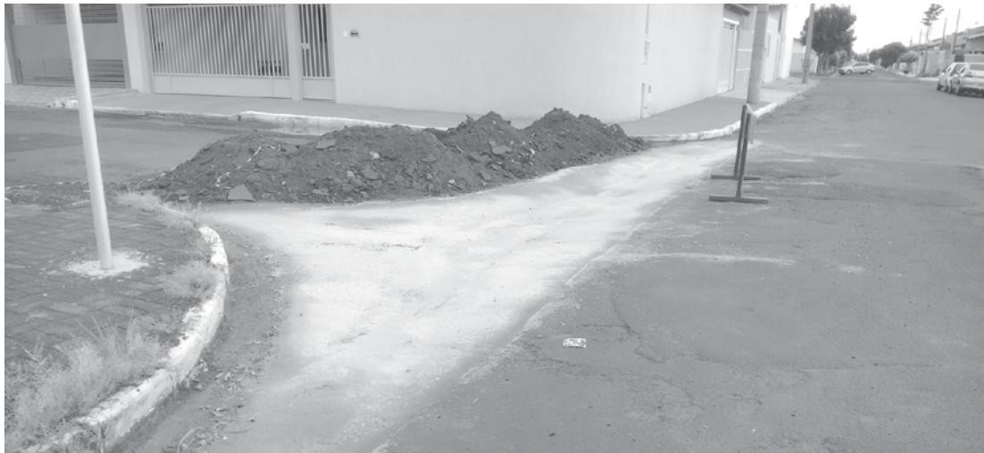
A construção dos “sarjetões” proporciona melhores condições aos motoristas, bem como facilita e minimiza os impactos dos veículos
