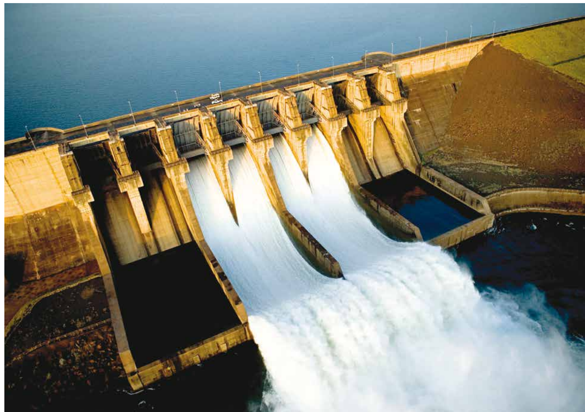
Controlando os Níveis dos Reservatórios: Imagem registra as comportas abertas nos últimos dias na Usina de Água Vermelha, em Ouroeste, onde a vazão subiu para 2.500 m³/s na manhã de ontem
