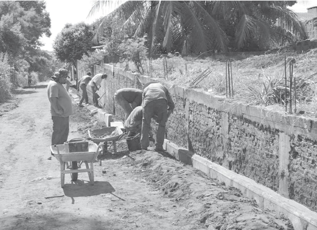
Serviços contemplam guias, sarjetas, sarjetões e uma dissipação para evitar novas erosões
