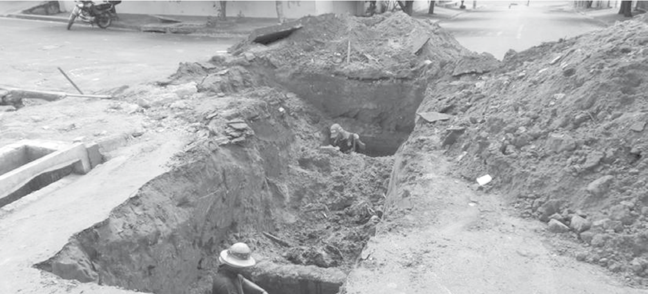
Inicialmente seria apenas um trabalho de limpeza das galerias, mas foi preciso muito mais, já que as quatro caixas coletoras e as três de distribuição, localizadas na Rua José Pereira, esquina com a Adriano Gregorini, estavam totalmente entupidas
