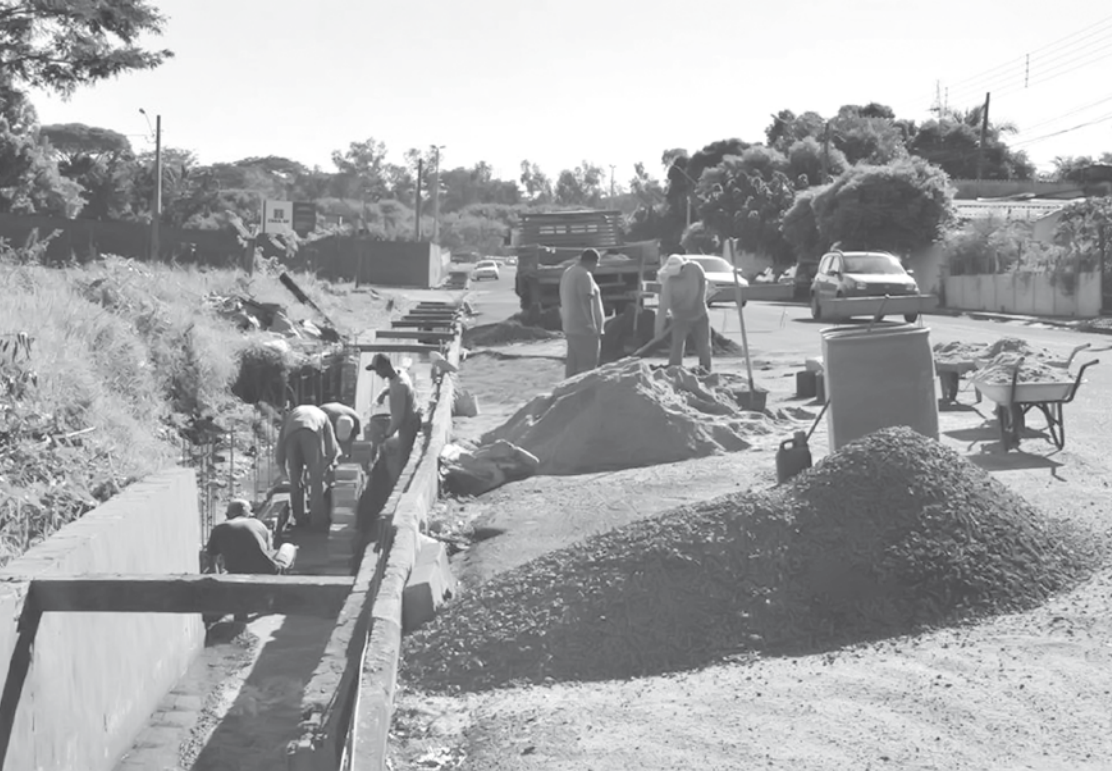
Trabalho dos servidores municipais está concentrado na recuperação da galeria de águas pluviais da Avenida Getúlio Vargas, no Jardim Paulista, danificada pela ação das chuvas
