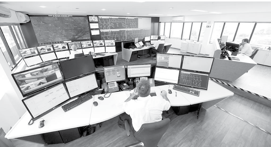
CENTRO DE OPERAÇÕES DA GERAÇÃO E ECLUSAS: Localizado em Bauru, o COGE da AES Tietê é responsável pela supervisão, comando e execução da operação das nossas nove usinas hidrelétricas e três pequenas centrais hidrelétricas, que somam 2.658 MW de capacidade instalada. Seu objetivo é maximizar os indicadores de disponibilidade, confiabilidade e segurança da operação. As equipes do COGE operam e mantêm as usinas dentro dos mais elevados padrões de desempenho exigidos pelo mercado. Para isso, administram diretrizes, recomendações e análises que possibilitam a operação centralizada.
