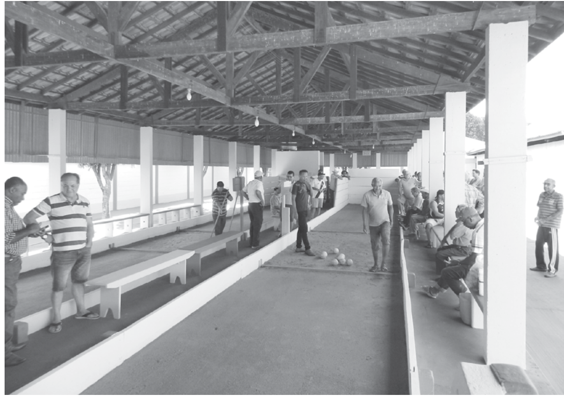
As obras de revitalização incluem a pintura, troca de madeiramento, compactação, além da área ser totalmente cimentada
