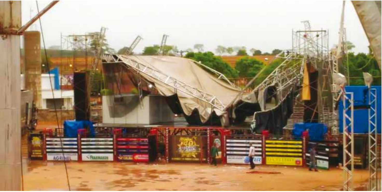
Em Américo de Campos, cobertura de palco desabou devido ao vento
