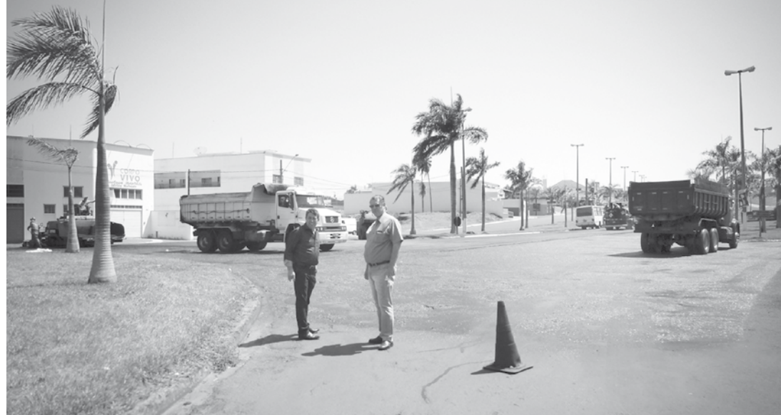
Prefeito Adilson e o engenheiro Francisco Belém acompanham a execução dos trabalhos de recapeamento da Av. Prefeito José Marciano da Silva
