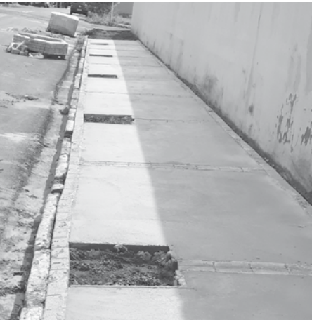
Calçamento foi feito conforme exigências e deixado canteiro para replantio
