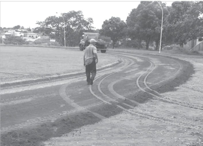
Todas as irregularidades do terreno foram niveladas
