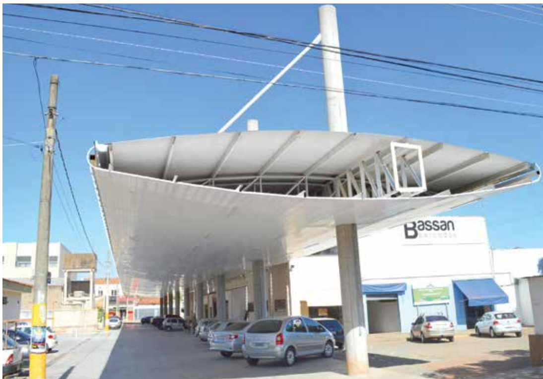
Obra é uma antiga reivindicação dos fernandopolenses e de muitos feirantes que trabalham no local de Territórios Rurais). Com iluminação e sinalização horizontal, a estrutura da Feira está sendo feita de concreto armado, a cobertura em estrutura metálica, além da instalação de sistemas integrados de água, energia e combate a incêndios.
