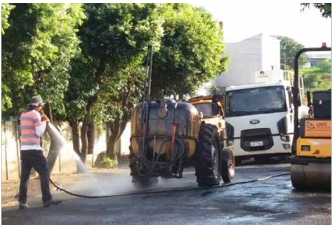
Quatro empresas estão na briga pelas obras de recape em Fernandópolis
