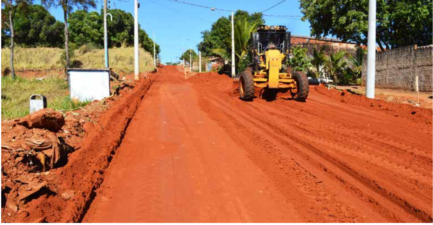
Rua sendo preparada para receber o asfaltamento
