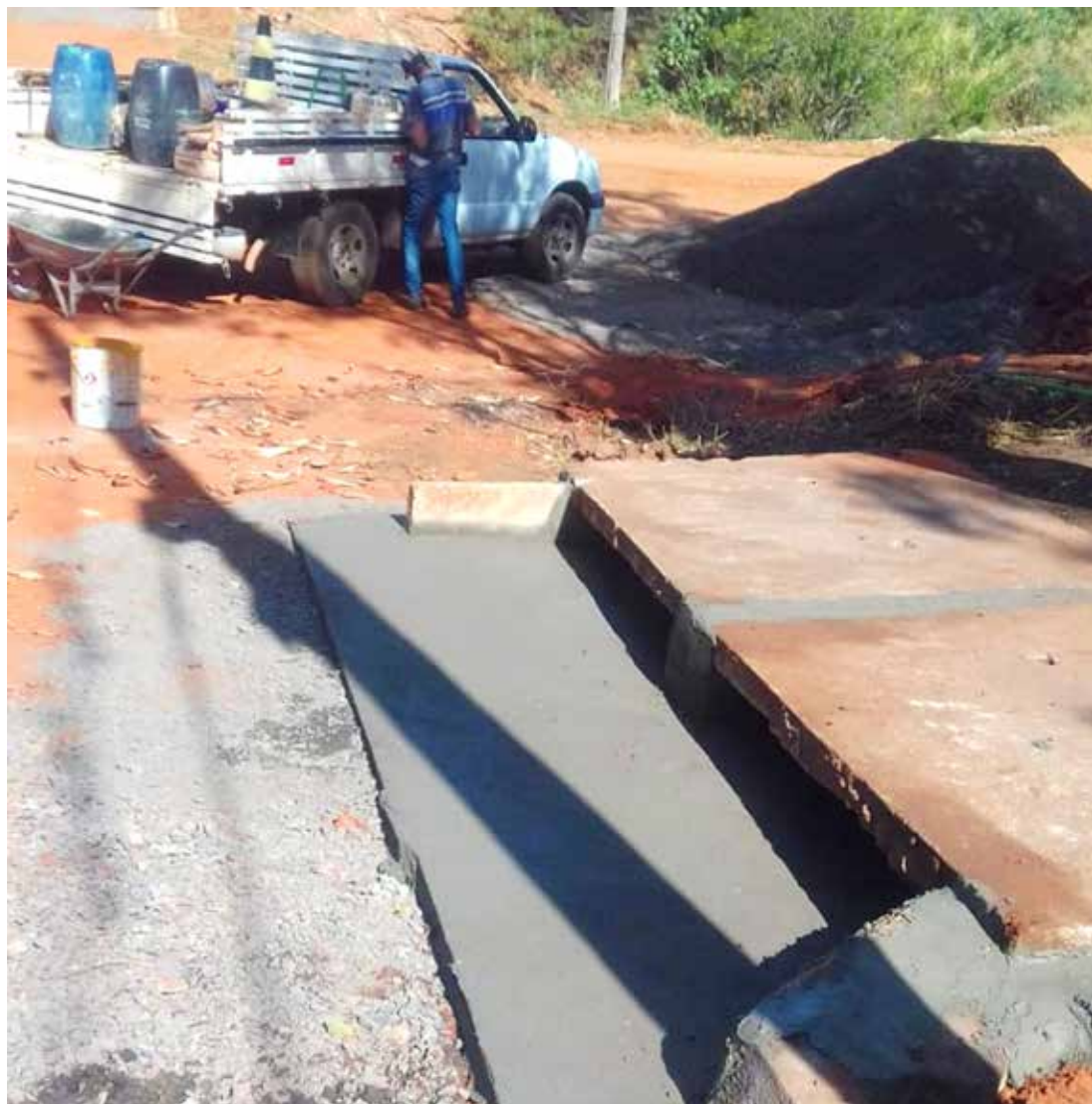
Serviço também contempla manutenção e troca de tampas
